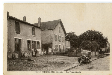
Ancienne fromagerie rue Billecard. Carte postale. Phot. Philippe Mairot IVR43_20167000175NUC4A
