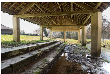
Sous l'ancien lavoir. Phot. Sonia Dourlot IVR43_20167001808NUC4A
