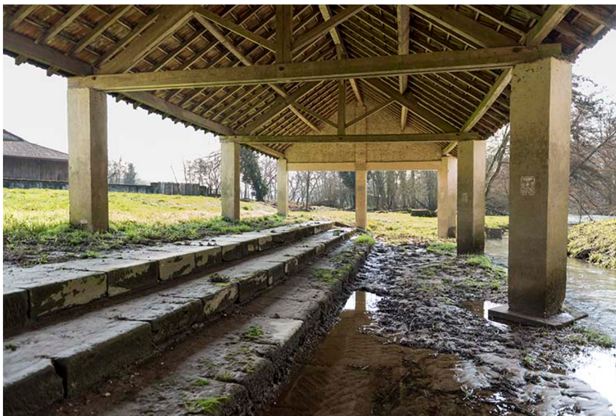
Sous l'ancien lavoir.
