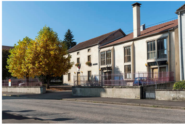
Vue sur la mairie depuis le nord-est. Phot. Sonia Dourlot IVR43_20157001392NUC4A
