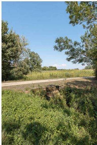
Vue du ponceau.
