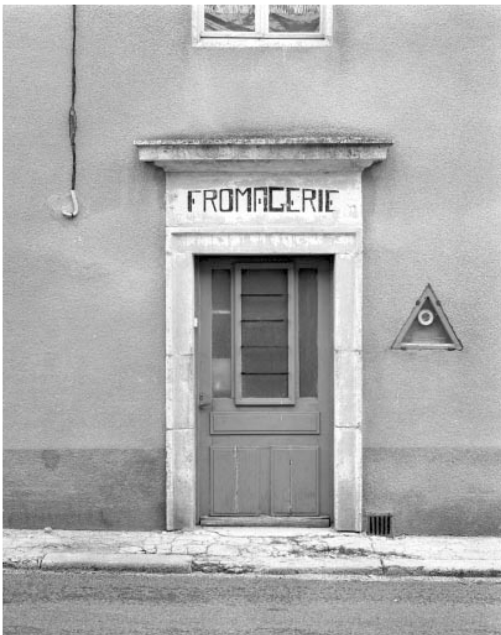
Porte d'entrée de la fromagerie.
