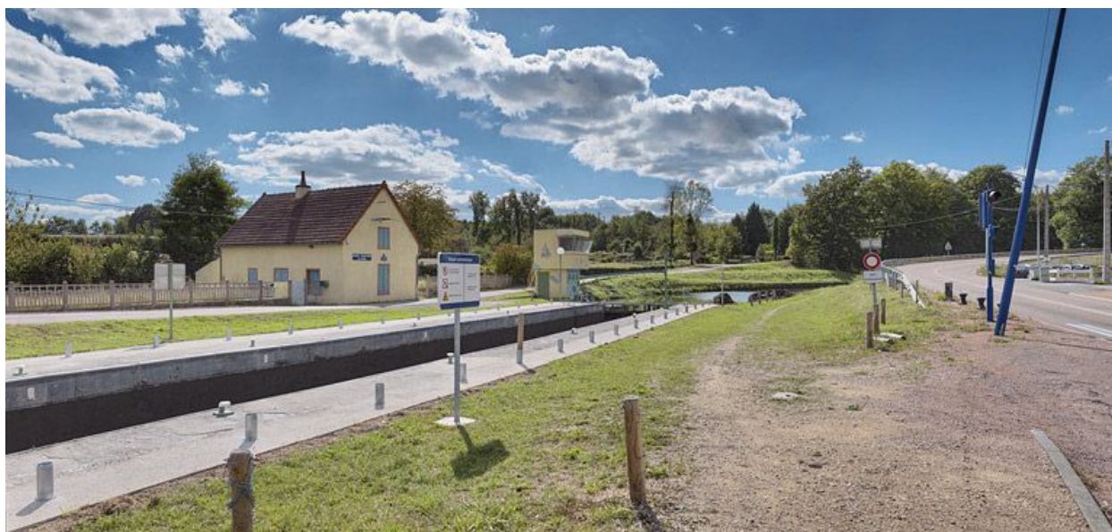
Site d'écluse pris d'aval.
