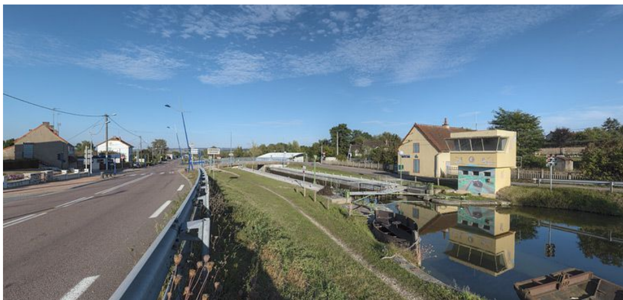
Site d'écluse pris d'amont.
