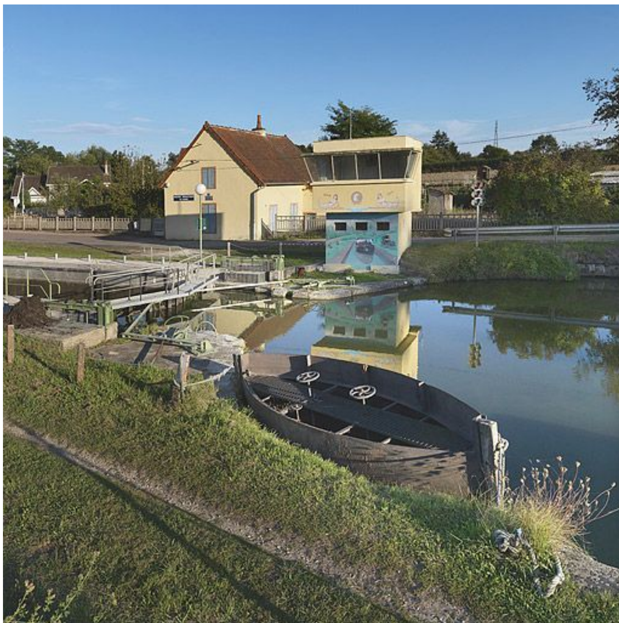
Site d'écluse pris d'amont.
