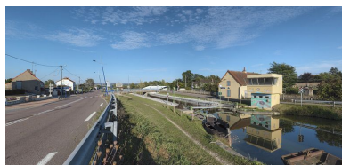
Site d'écluse pris d'amont. Phot. Thierry Kuntz IVR26_20127100303NUC4AQ
