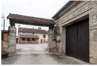
Ancienne maison des soeur. Phot. Jérôme Mongreville IVR43_20167000512NUC4A
