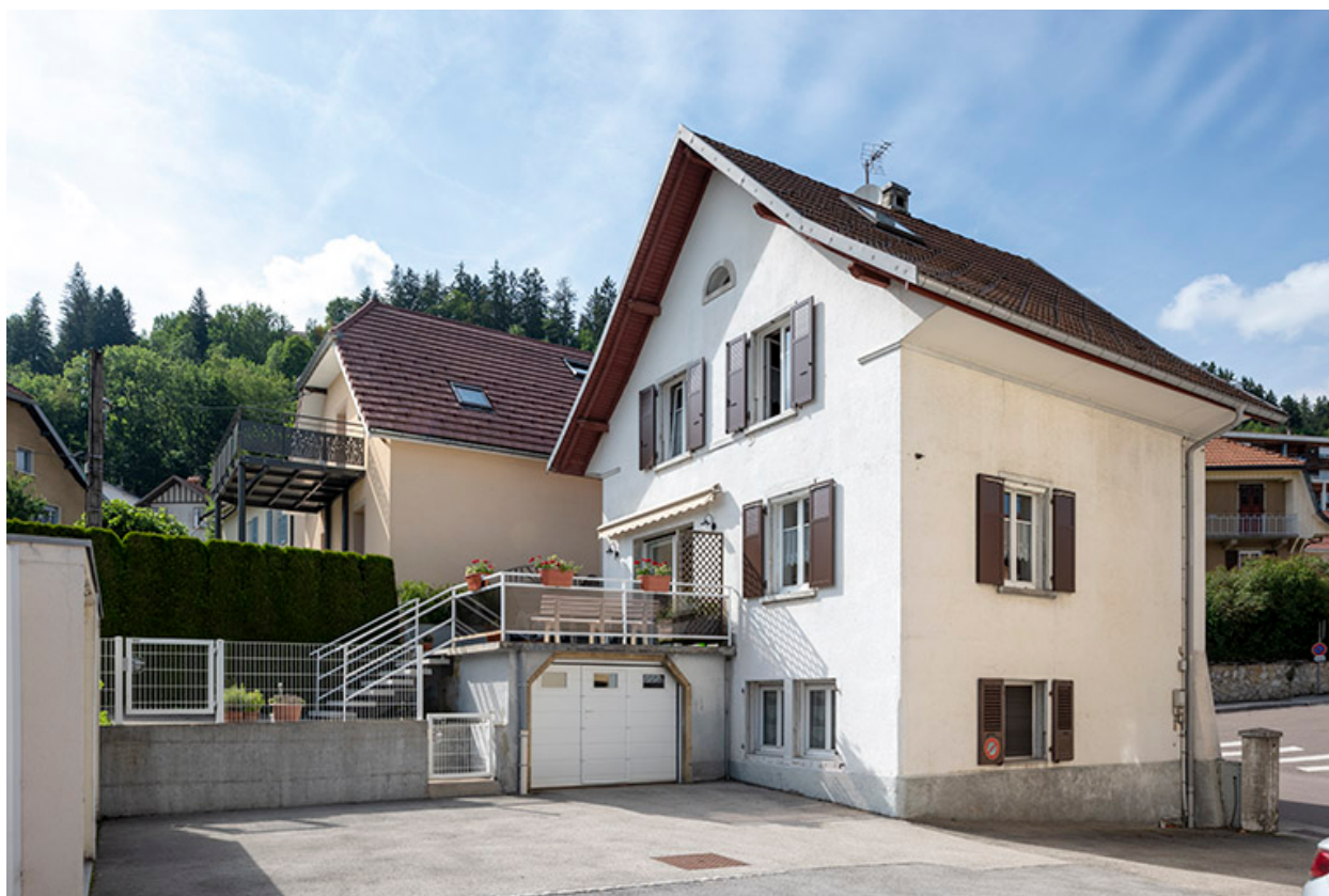
Façades postérieure et latérale gauche.
