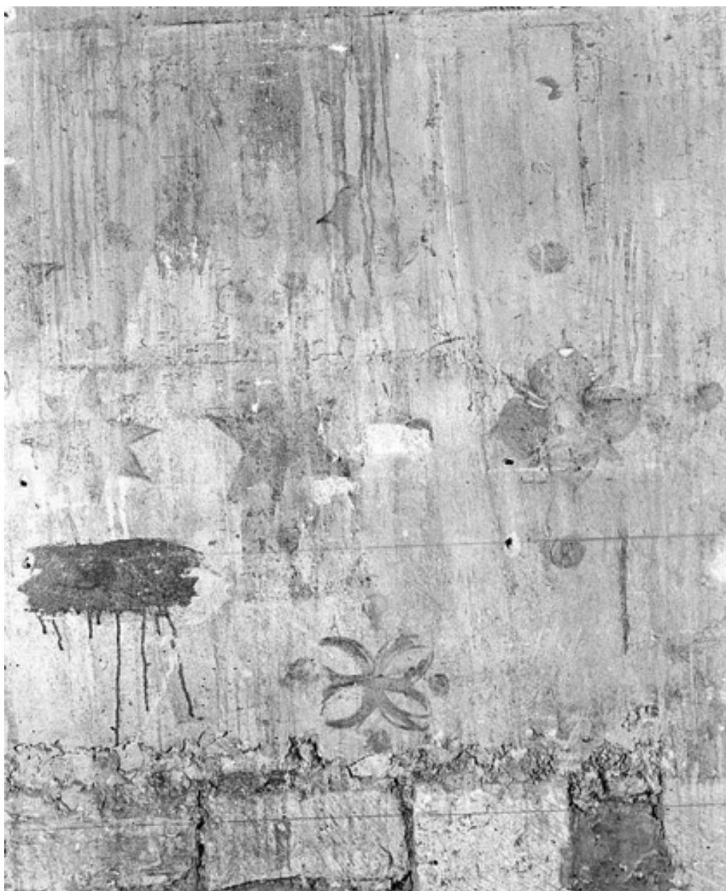
Choeur, mur sud : traces de décor.
