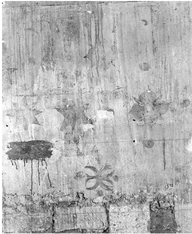
Choeur, mur sud : traces de décor.
