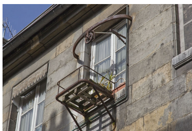
Aile gauche : détail d'un monte-charge.
