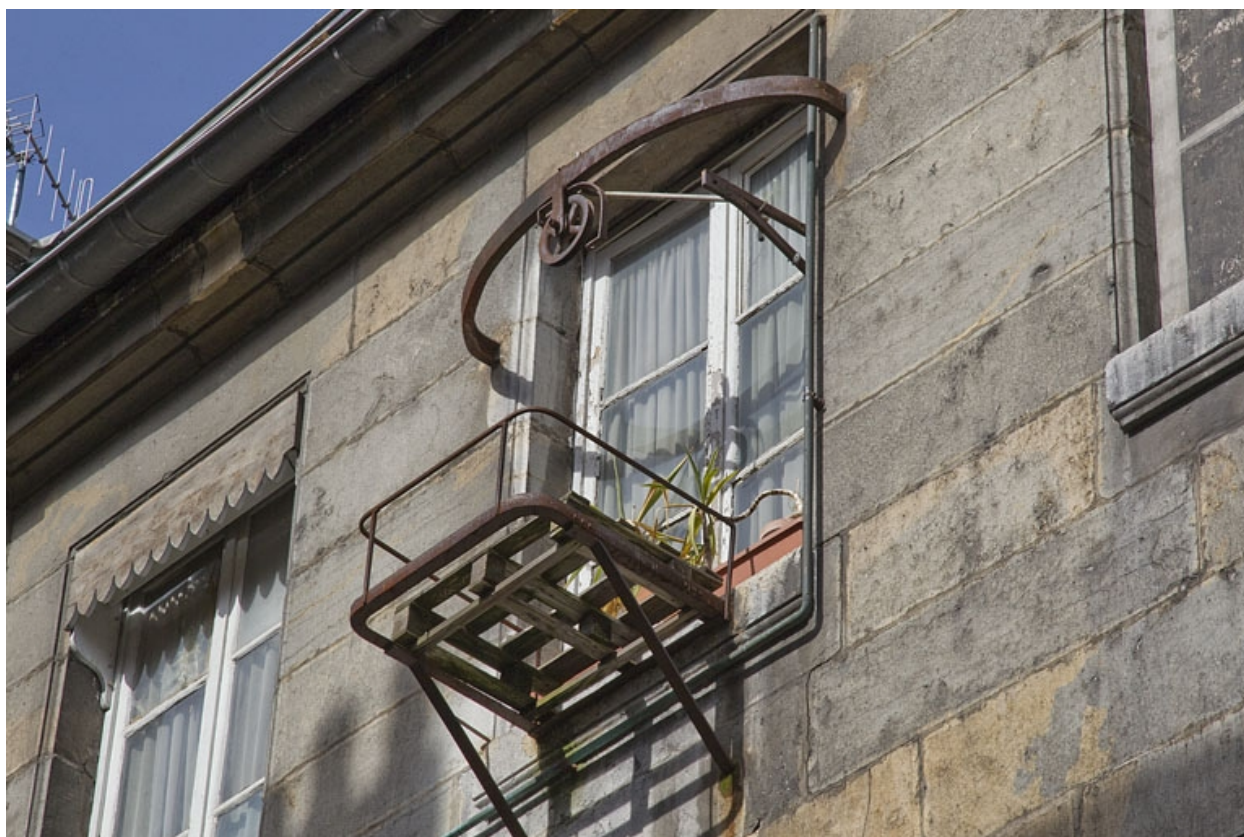
Aile gauche : détail d'un monte-charge.
