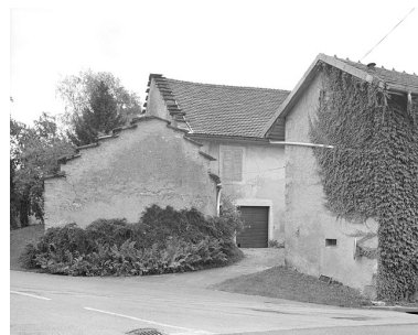
Façade antérieure de la ferme. Phot. Jérôme Mongreville IVR43_19963901425X
