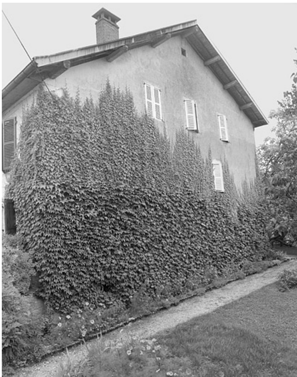
Face sud de la ferme.
