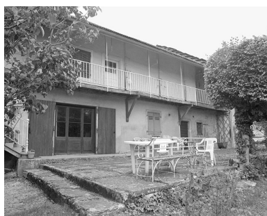
Façade postérieure de la ferme. Phot. Jérôme Mongreville IVR43_19963901431X
