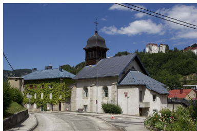
Façade latérale droite. Phot. Yves Sancey IVR43_20103900405NUC2A
