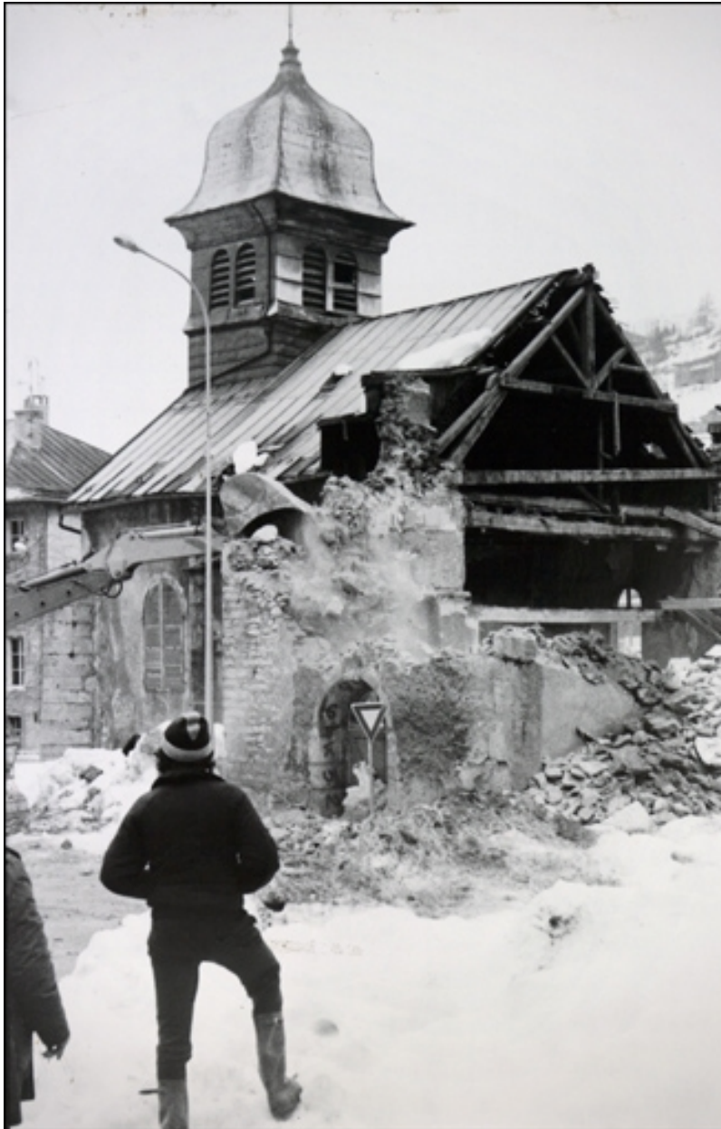
[Démolition du chœur de l'église], 1981
