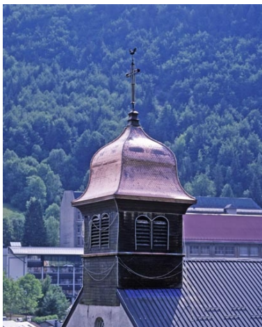
Clocher, depuis le nord-ouest. Phot. Yves Sancey IVR43_20033900906XA
