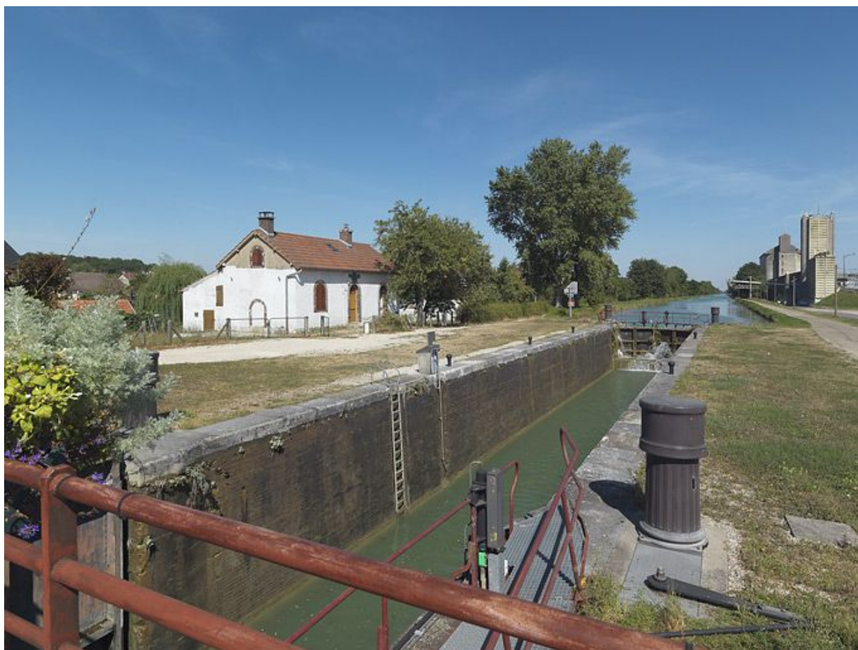
Panorama du site d'écluse pris d'aval, du pont sur écluse. De gauche à droite : site d'écluse, silos. Le bief est vide : on voit la maçonnerie des bajoyers.
