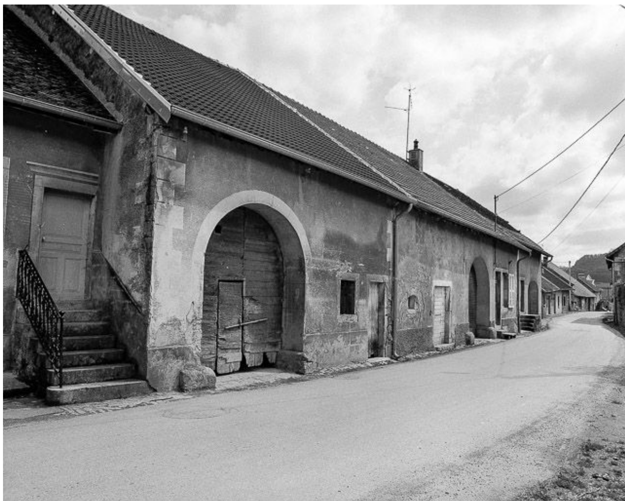
Fermes situées rue du Dessous.
