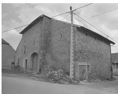
Ferme située rue du Dessous. Phot. Dominique Dominguez IVR43_19783900154X
