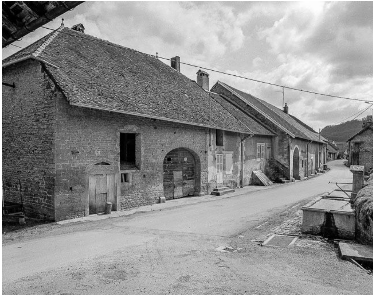
Fermes situées rue du Dessous.
