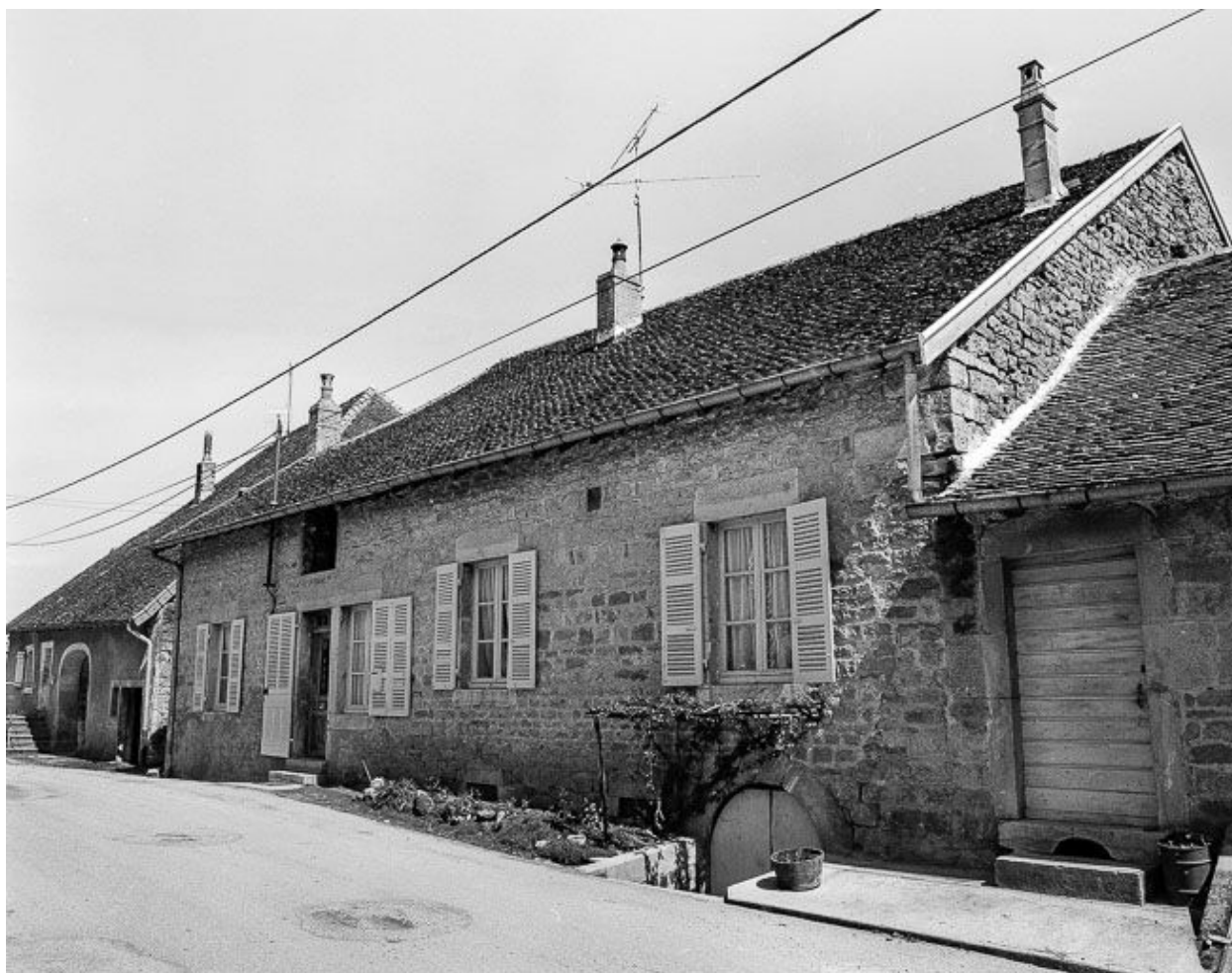
Fermes situées rue du Dessous.
