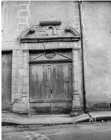
Portail de maison. Phot. Dominique Dominguez IVR43_19783900158X
