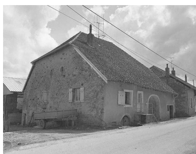
Ferme située rue du Dessous. Phot. Dominique Dominguez IVR43_19783900148X
