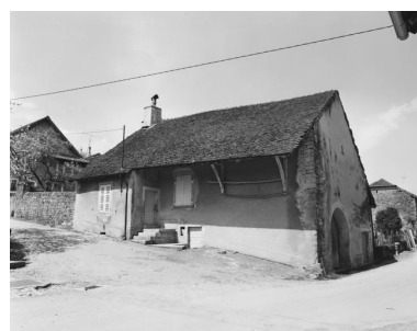
Ferme située rue du Dessous. Phot. Dominique Dominguez IVR43_19783900159X
