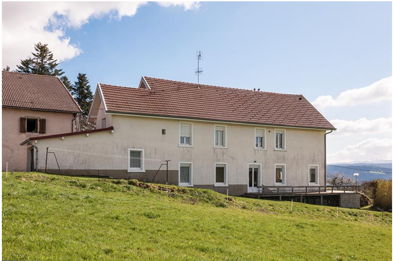
Atelier : façade postérieure.
