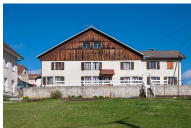
Ferme : façade antérieure. Phot. Jérôme Mongreville IVR43_20142500282NUC4A
