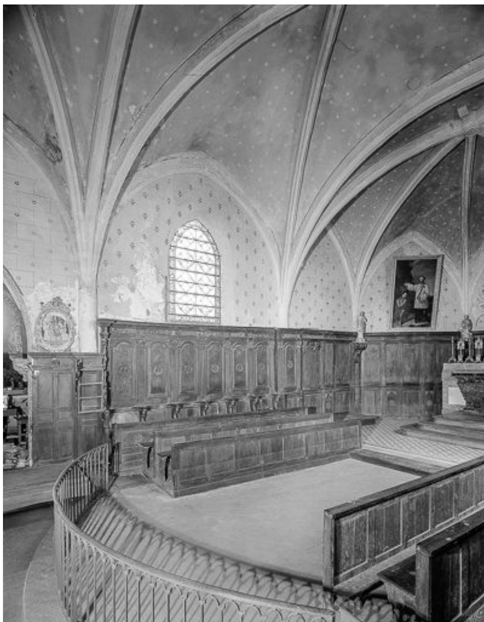
Intérieur : chœur, mur gauche.
