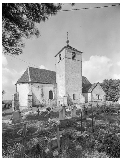
Façade latérale gauche : vue de trois quarts.
