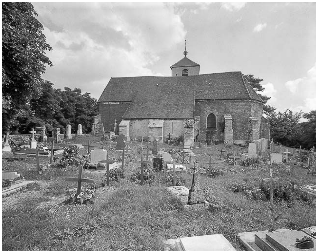
Façade latérale droite.
