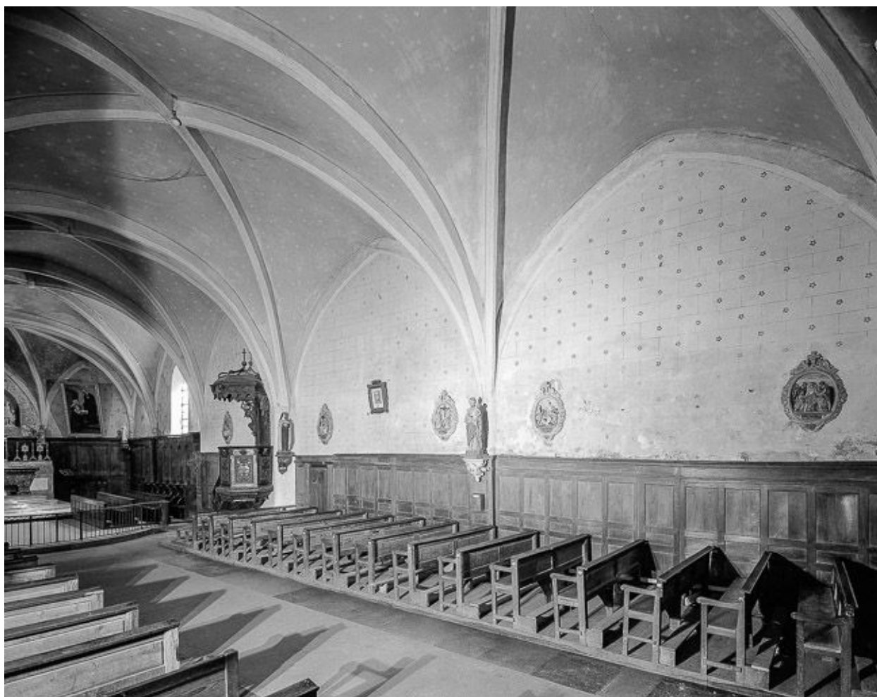
Intérieur : nef, mur droit vu de l'entrée.
