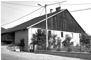
Vue de trois quarts. Phot. Dominique Dominguez IVR43_19792500869X
