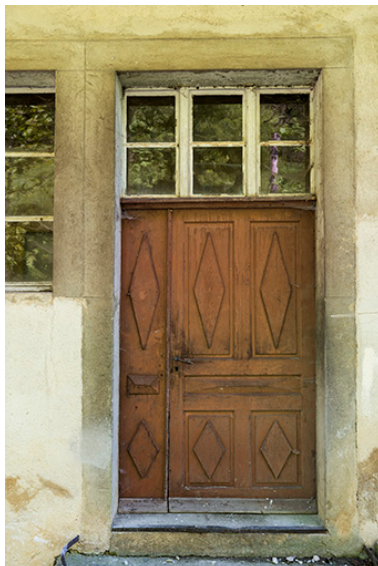
Usine, façade antérieure : porte.
