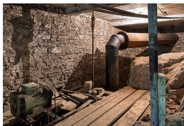
Usine : conduit d'amenée d'eau de la turbine, au 1er étage de soubassement. Phot. Sonia Dourlot IVR43_20172500024NUC4A
