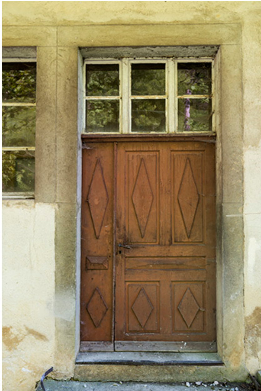
Usine, façade antérieure : porte.
