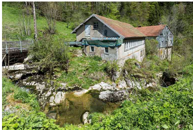
Usine et ancien moulin, depuis le sud.
