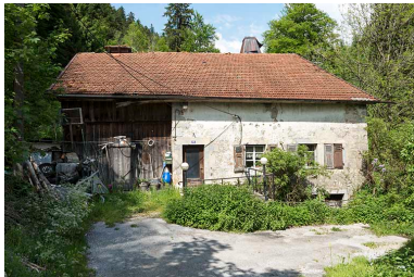
Ancien moulin : façade antérieure. Phot. Sonia Dourlot IVR43_20172500549NUC4A
