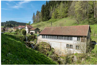
Vue d'ensemble, depuis le nord-est. Bassin de retenue, maison et remise à l'arrière-plan, usine au premier plan.
