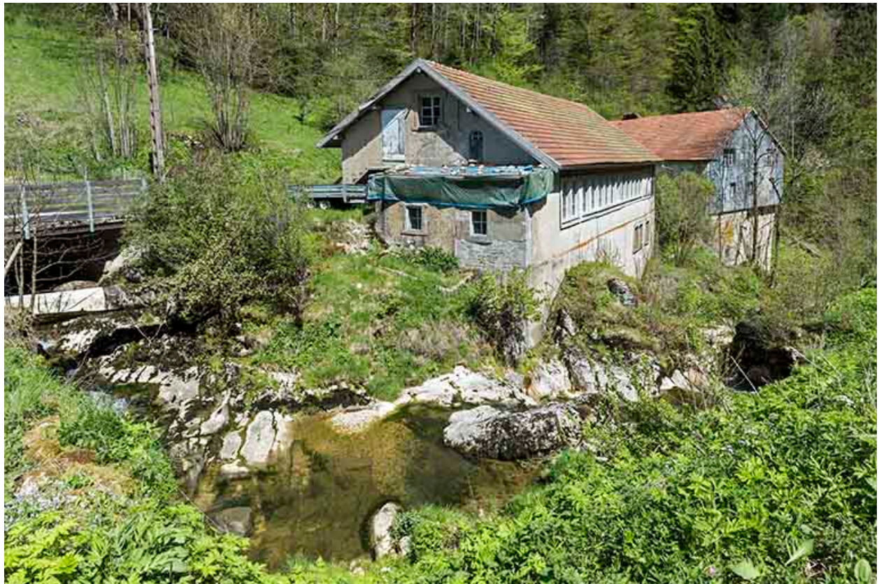
Usine et ancien moulin, depuis le sud.
