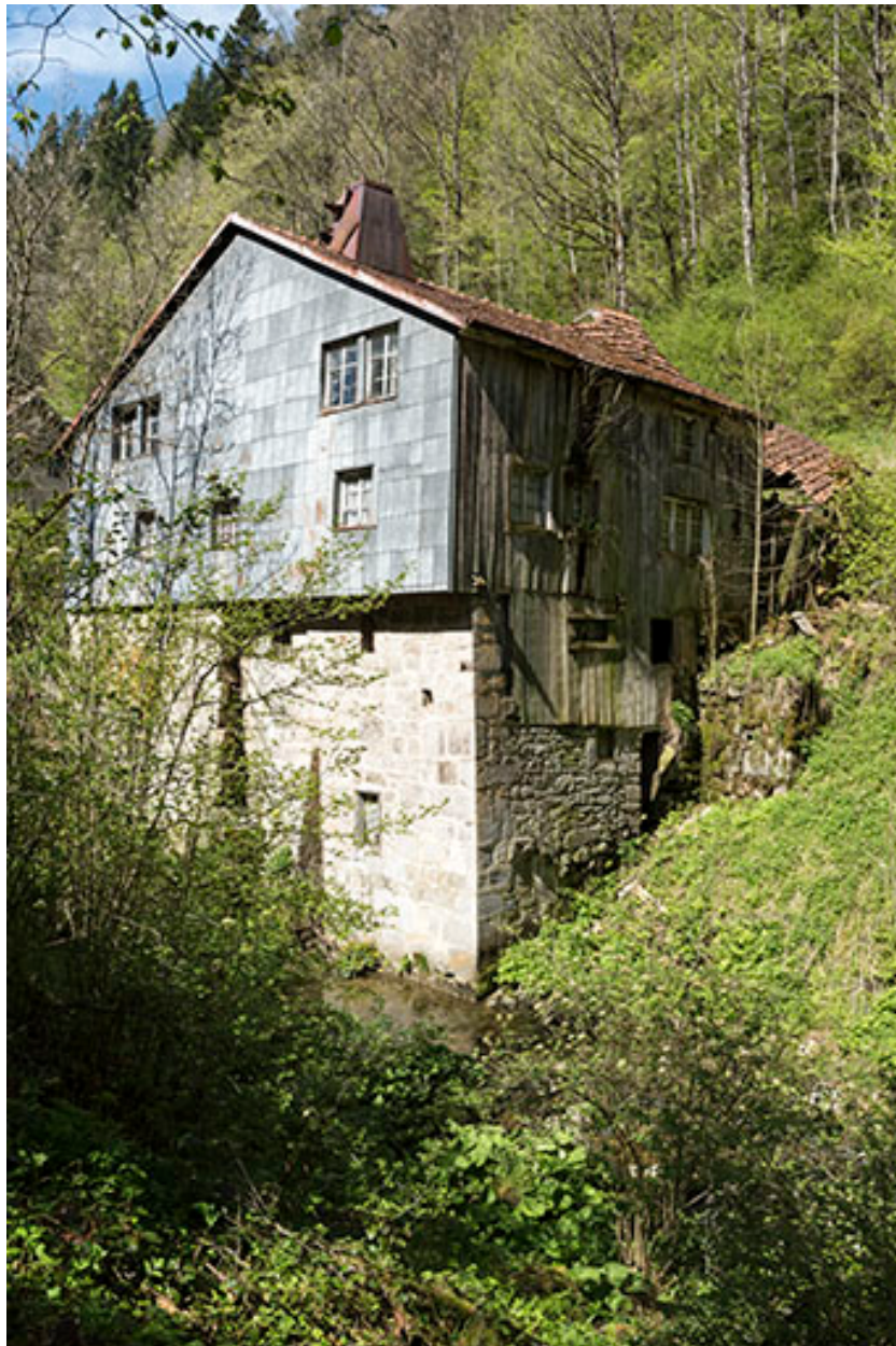
Ancien moulin : façades postérieure et latérale droite.
