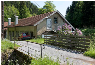
Usine : façades antérieure et latérale droite.
