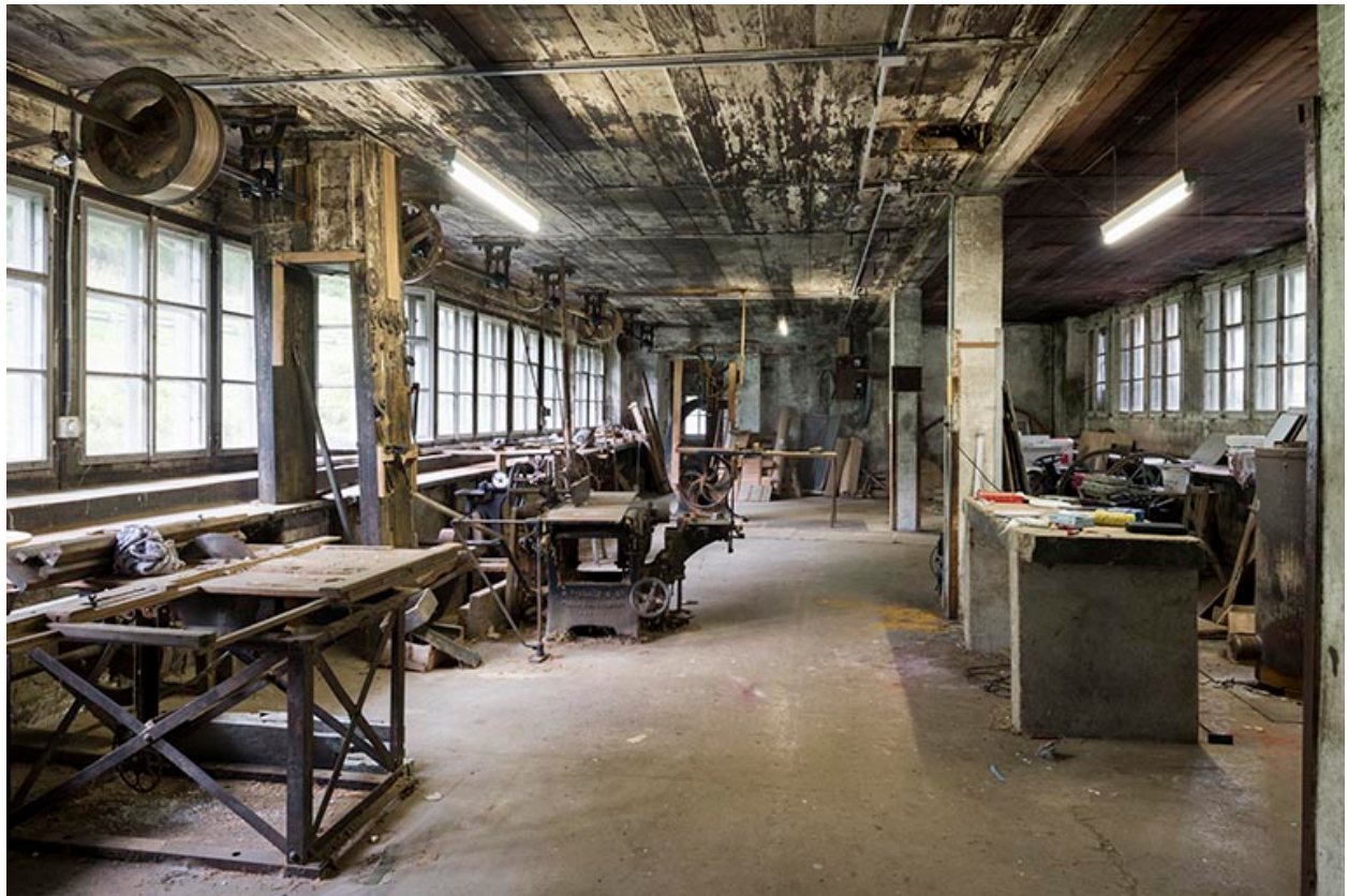
Usine : atelier de menuiserie au rez-de-chaussée.
