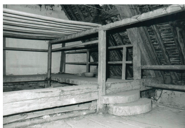
Etage de comble du bâtiment conventuel. Etendoirs (?), 1997. Phot. auteur inconnu IVR43_20253900090NUC4A
