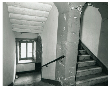
Bâtiment conventuel. Escalier du 17e siècle, 1997. Phot. auteur inconnu IVR43_20253900075NUC4A
