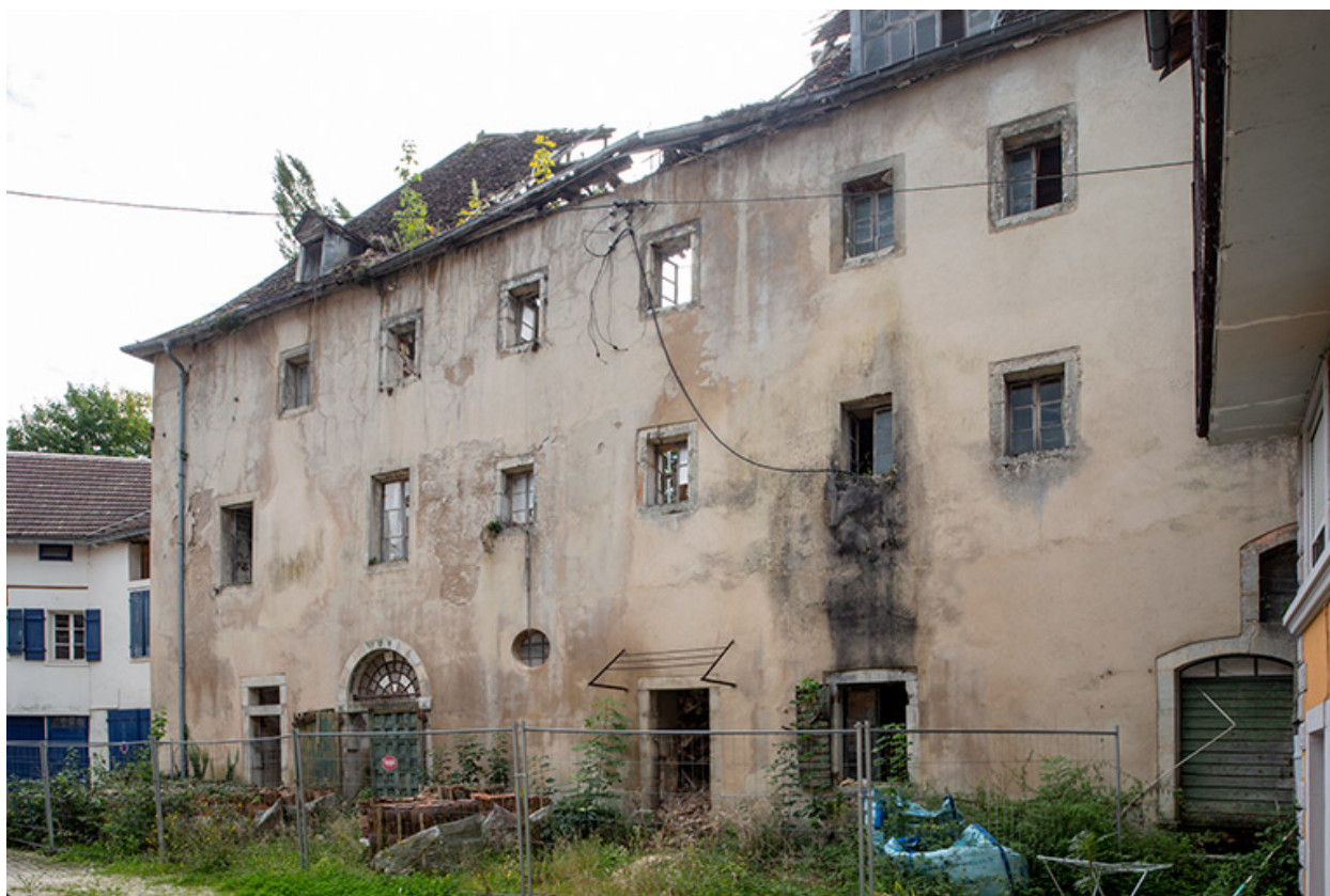
Façade nord du grand bâtiment conventuel.
