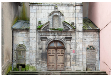
Partie basse de la façade nord. Phot. Jérôme Mongreville IVR43_20243901033NUC4A
