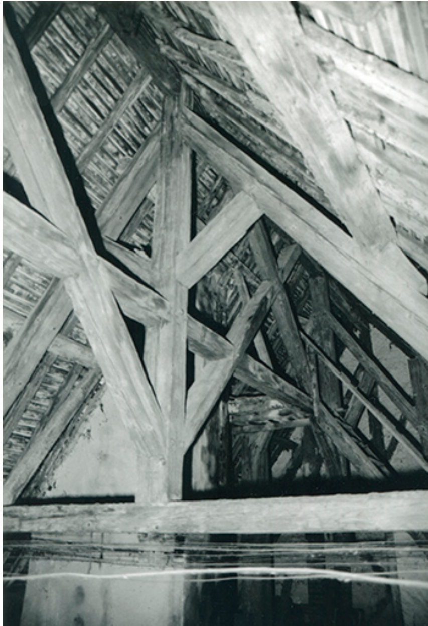
Charpente du bâtiment conventuel, 1997.
