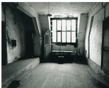
Etage de comble du bâtiment conventuel. Atelier, 1997. Phot. auteur inconnu IVR43_20253900089NUC4A
