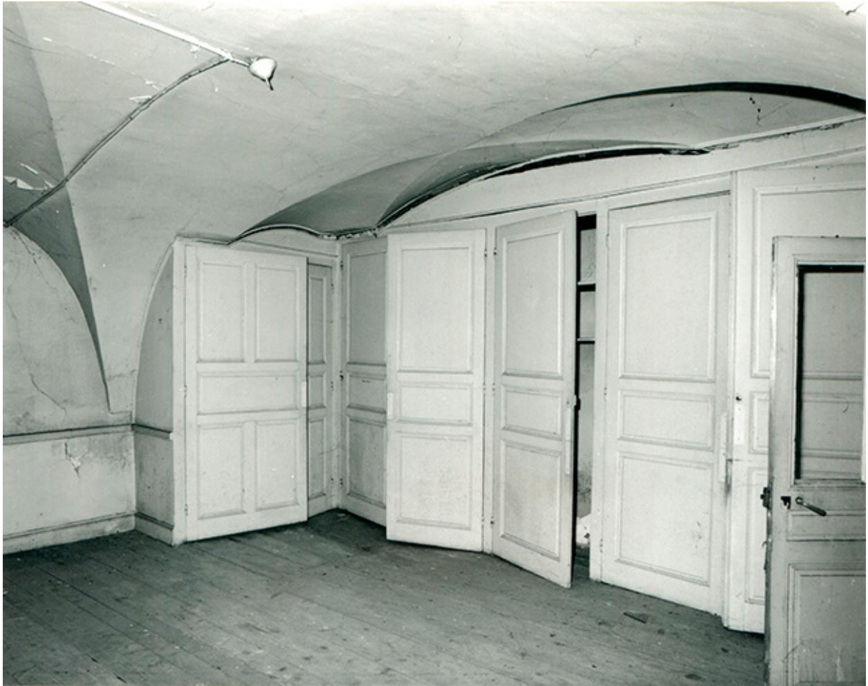
Rez-de-chaussée du bâtiment conventuel. Pièce côté sud, 1997.
