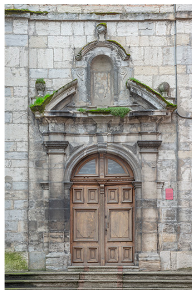
Façade nord. Porte centrale. Phot. Jérôme Mongreville IVR43_20243901034NUC4A
