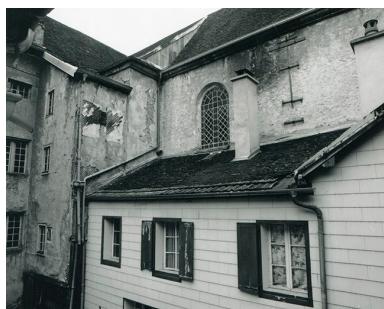
Flanc est de l'église, 1997. Phot. auteur inconnu IVR43_20253900061NUC4A
