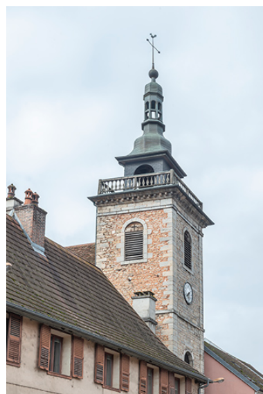
Le clocher vu de trois quarts gauche. Phot. Jérôme Mongreville IVR43_20243901036NUC4A
