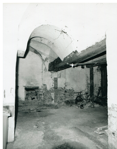
Rez-de-chaussée du bâtiment conventuel, 1997. Phot. auteur inconnu IVR43_20253900078NUC4A
