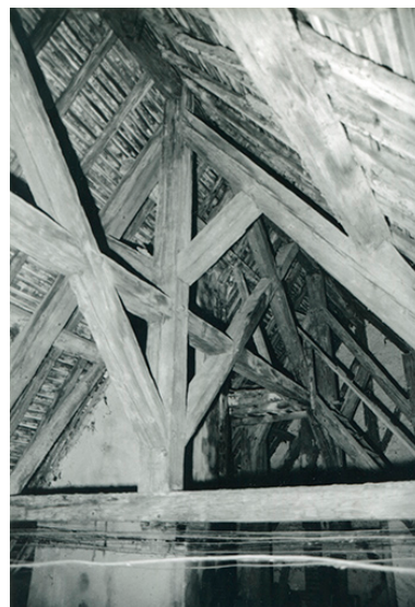
Charpente du bâtiment conventuel, 1997. Phot. auteur inconnu IVR43_20253900091NUC4A
