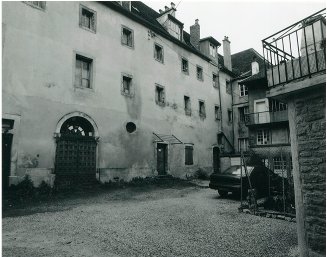
Façade nord du bâtiment conventuel, 1997.
