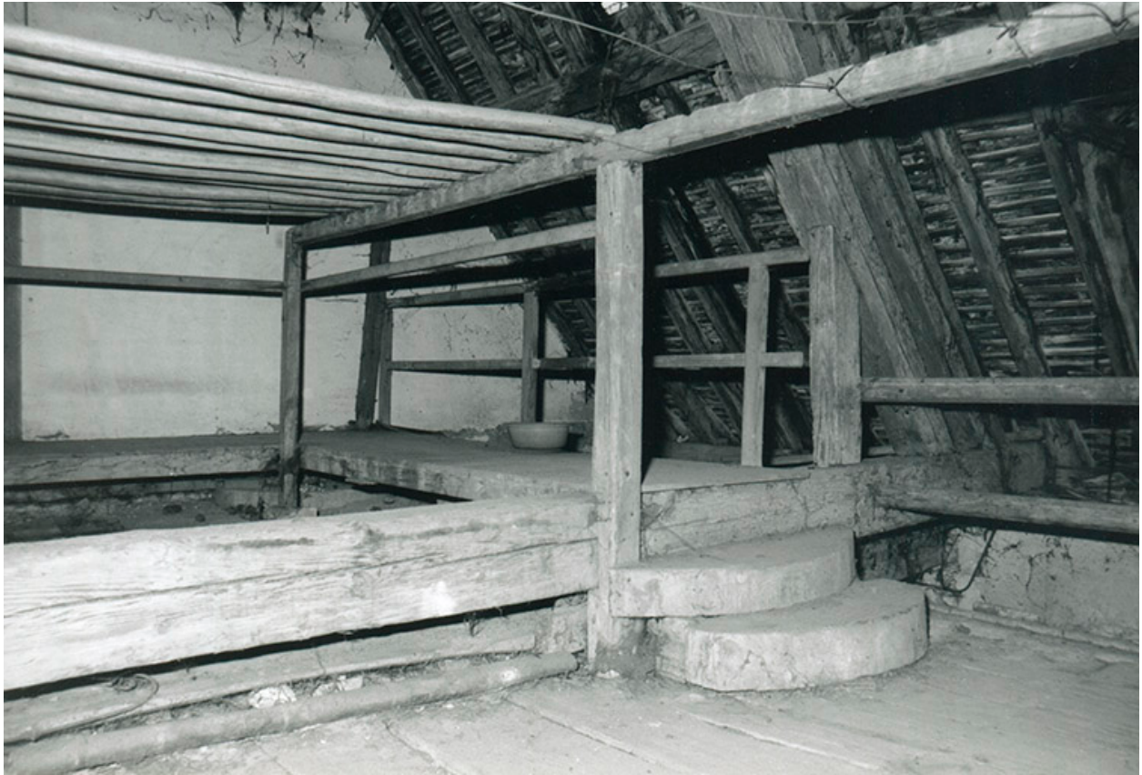
Etage de comble du bâtiment conventuel. Etendoirs (?), 1997.
