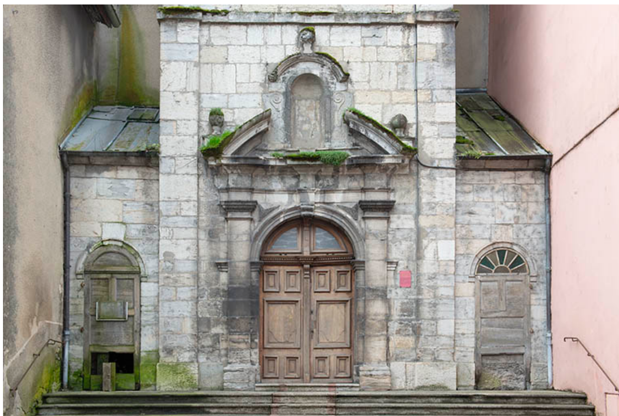
Partie basse de la façade nord.
