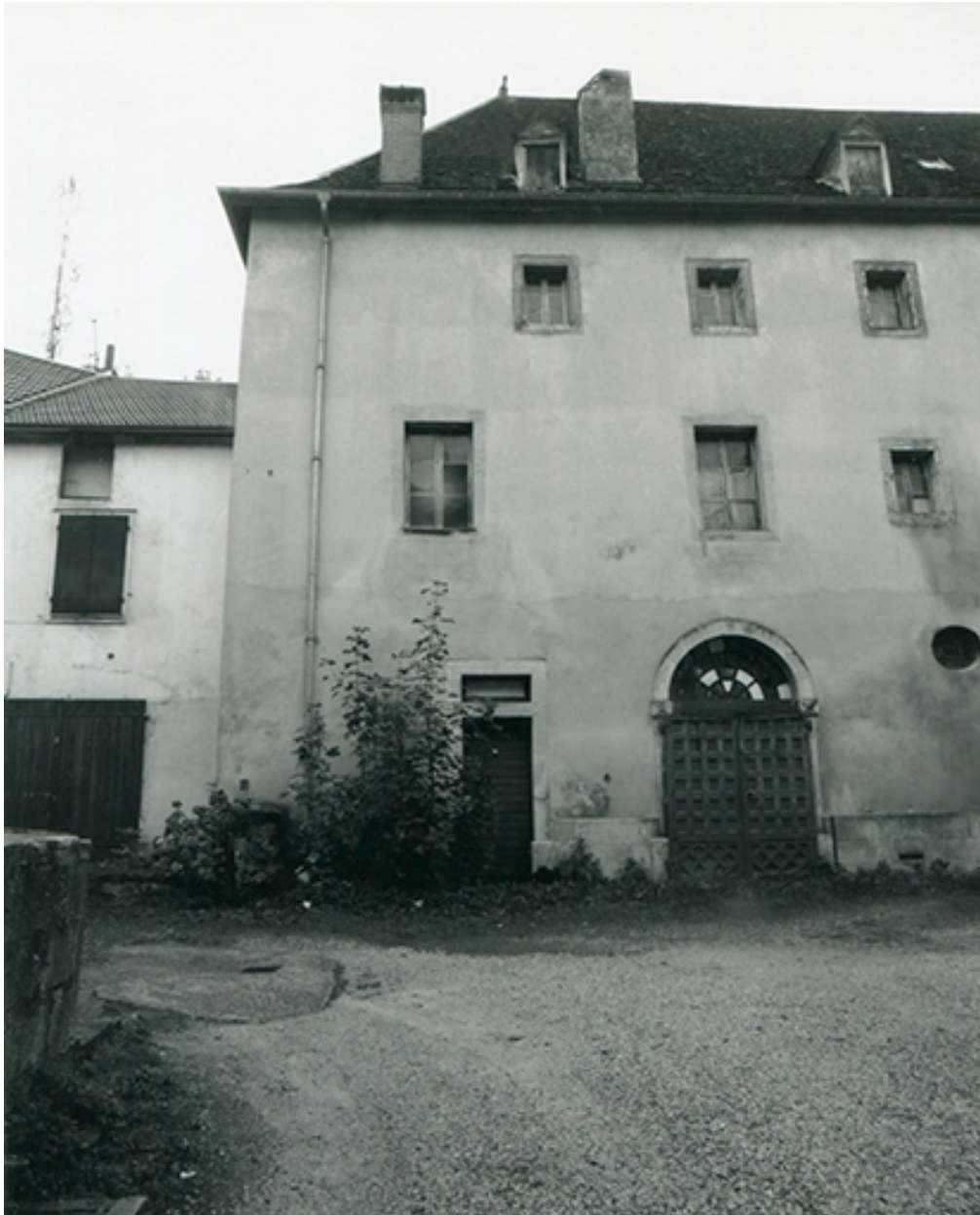
Façade nord du bâtiment conventuel. Travées orientales, 1997.
