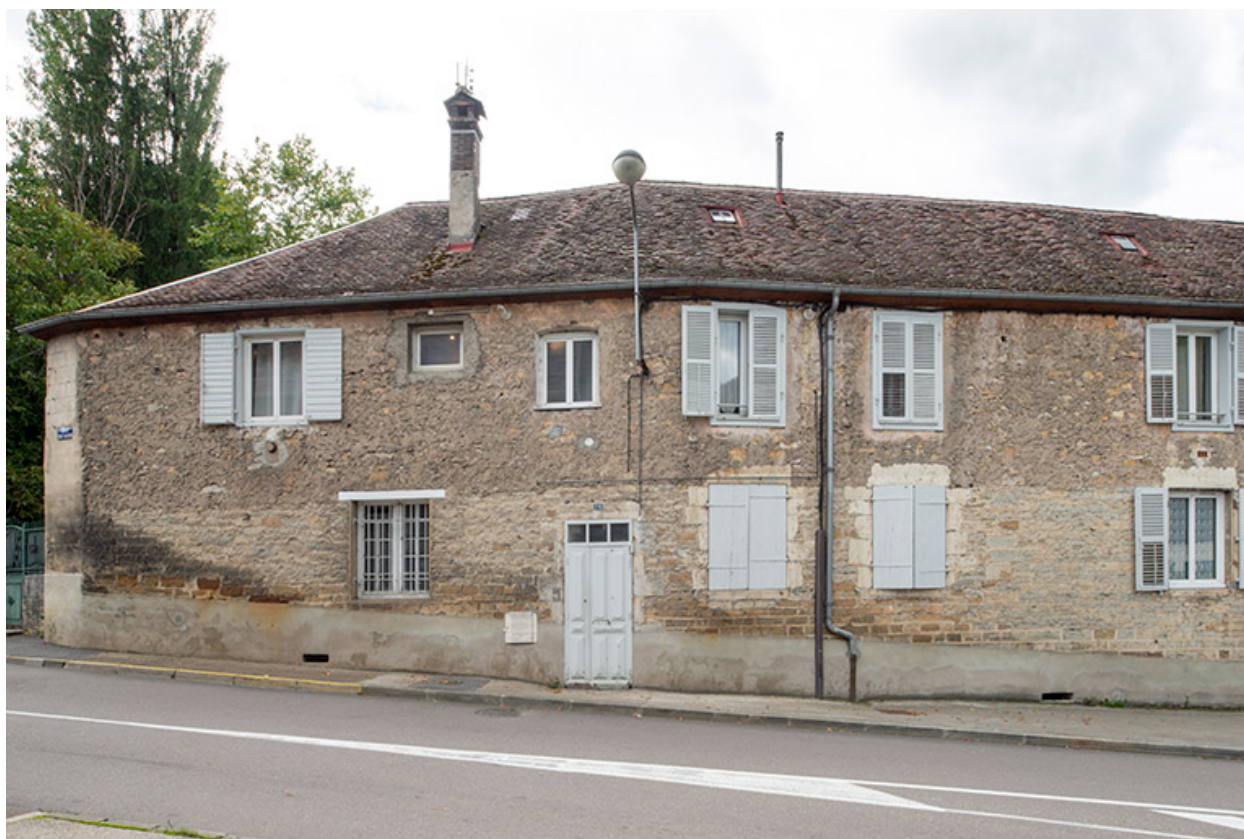
Extrémité est des bâtiments conventuels. Façade nord.
