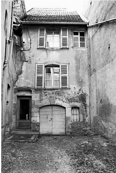
Façade antérieure sur cour.
