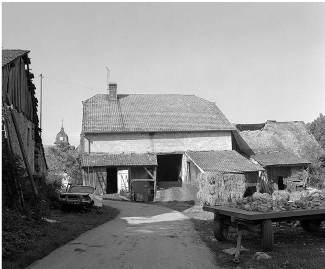
Face latérale : l'entrée de grange.
