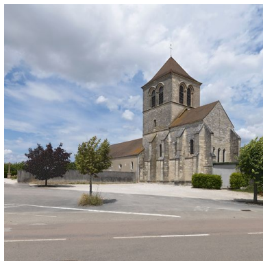
Eglise Saint-Pierre : vue d'ensemble.
