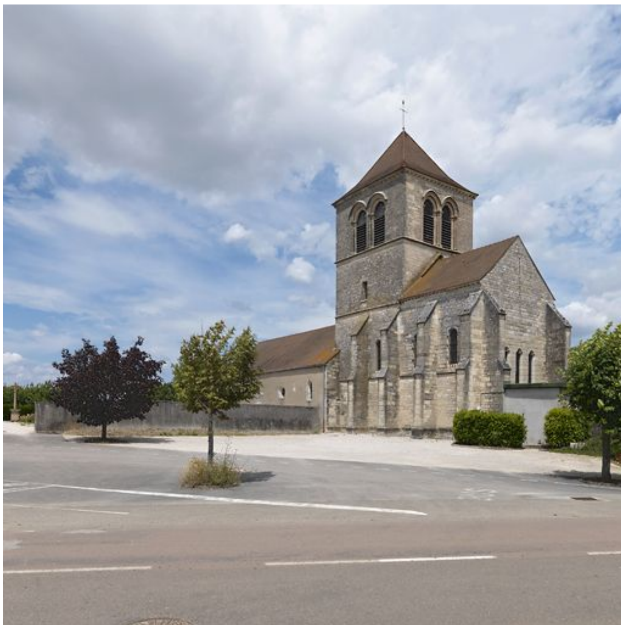
Eglise Saint-Pierre : vue d'ensemble.
