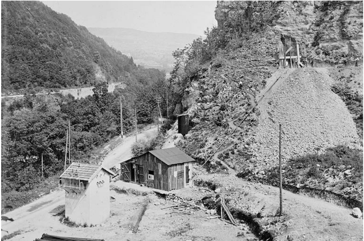
Attaque n° 4. Sortie aval du grand souterrain de 1750 m à Porte-Sachet. Poste de transformation et compression d'air n° 3.
