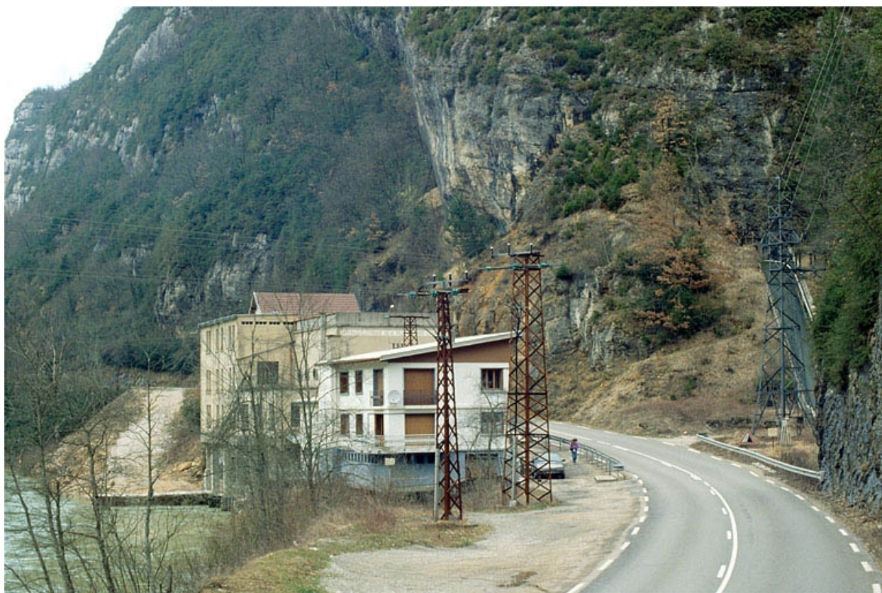
Vue d'ensemble : logement d'ouvriers et centrale.
