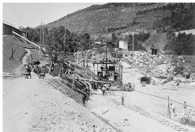
Chantier du barrage. Poste de transformation et compression d'air n° 1. Mur de rive de la prise d'eau. Chantier de concassage et de broyage et bétonnière. Alimentation d'eau et magasin des chaux et de ciment. Phot. Jérôme Mongreville, Phot. Jules Debachy IVR43_19923900315X
