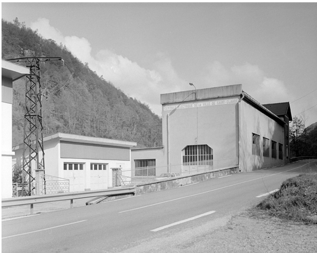
Façade antérieure de la centrale.
