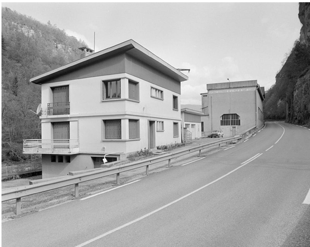
Logement d'ouvriers et centrale.
