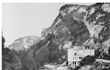
Chassal (Jura). Centrale électrique de St-Claude. Phot. Jérôme Mongreville IVR43_19903900328X
