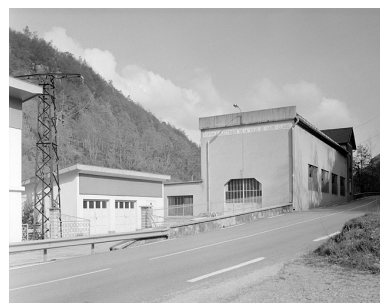
Façade antérieure de la centrale. Phot. Jérôme Mongreville IVR43_19923900330X
