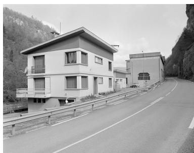
Logement d'ouvriers et centrale. Phot. Jérôme Mongreville IVR43_19923900326X
