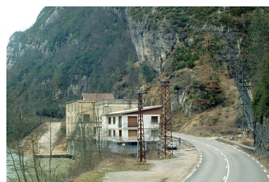
Vue d'ensemble : logement d'ouvriers et centrale. Phot. Laurent Poupard IVR43_19913901162ZA
