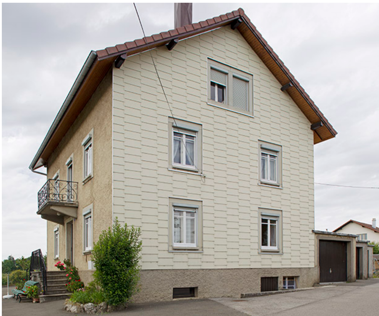
Façade latérale droite.
