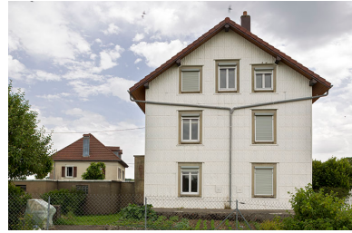
Façade latérale gauche. Phot. Sonia Dourlot
