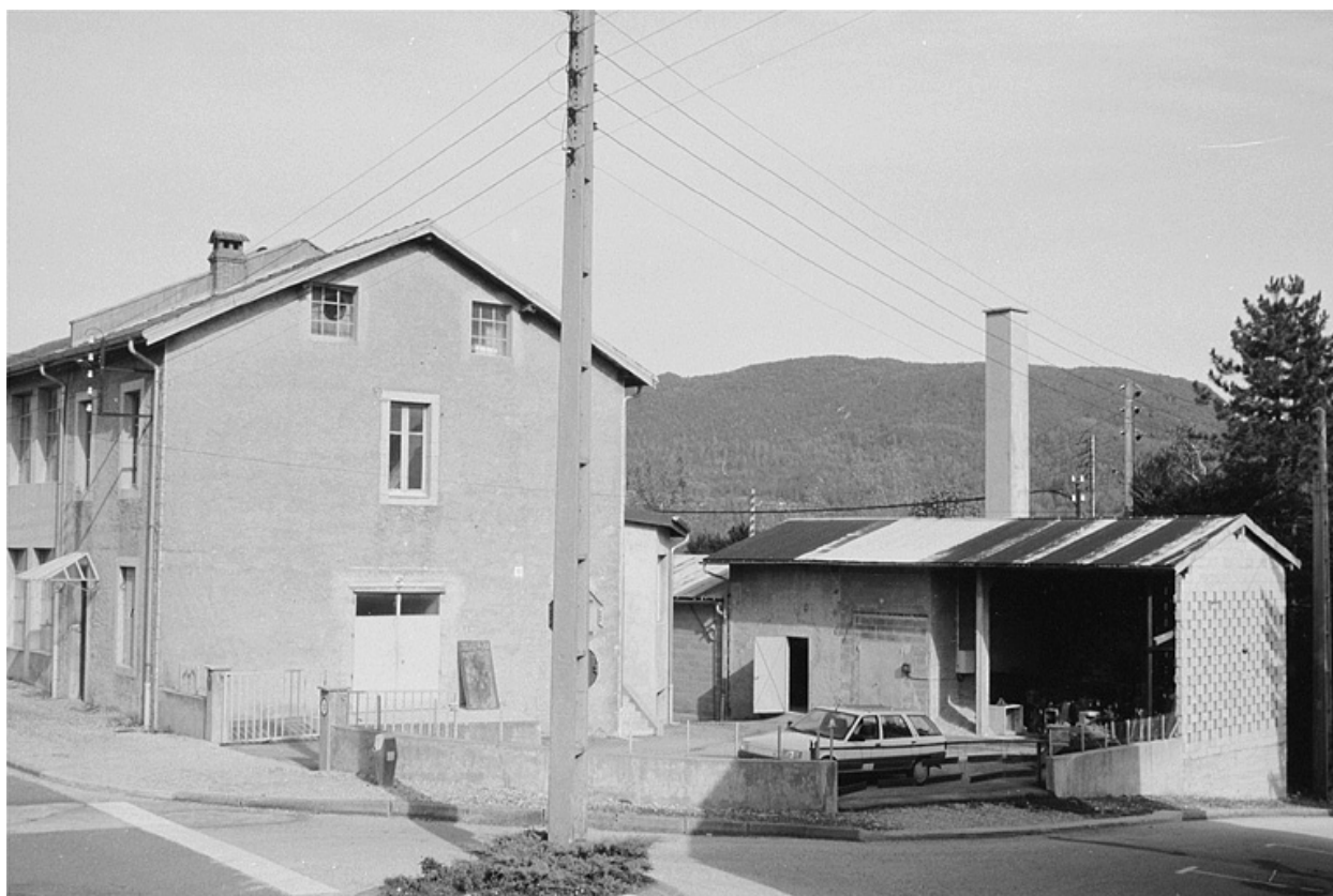
Façade latérale droite et chaufferie.
