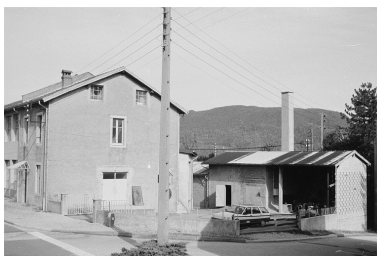
Façade latérale droite et chaufferie. Phot. Laurent Poupard IVR43_19913900974Z
