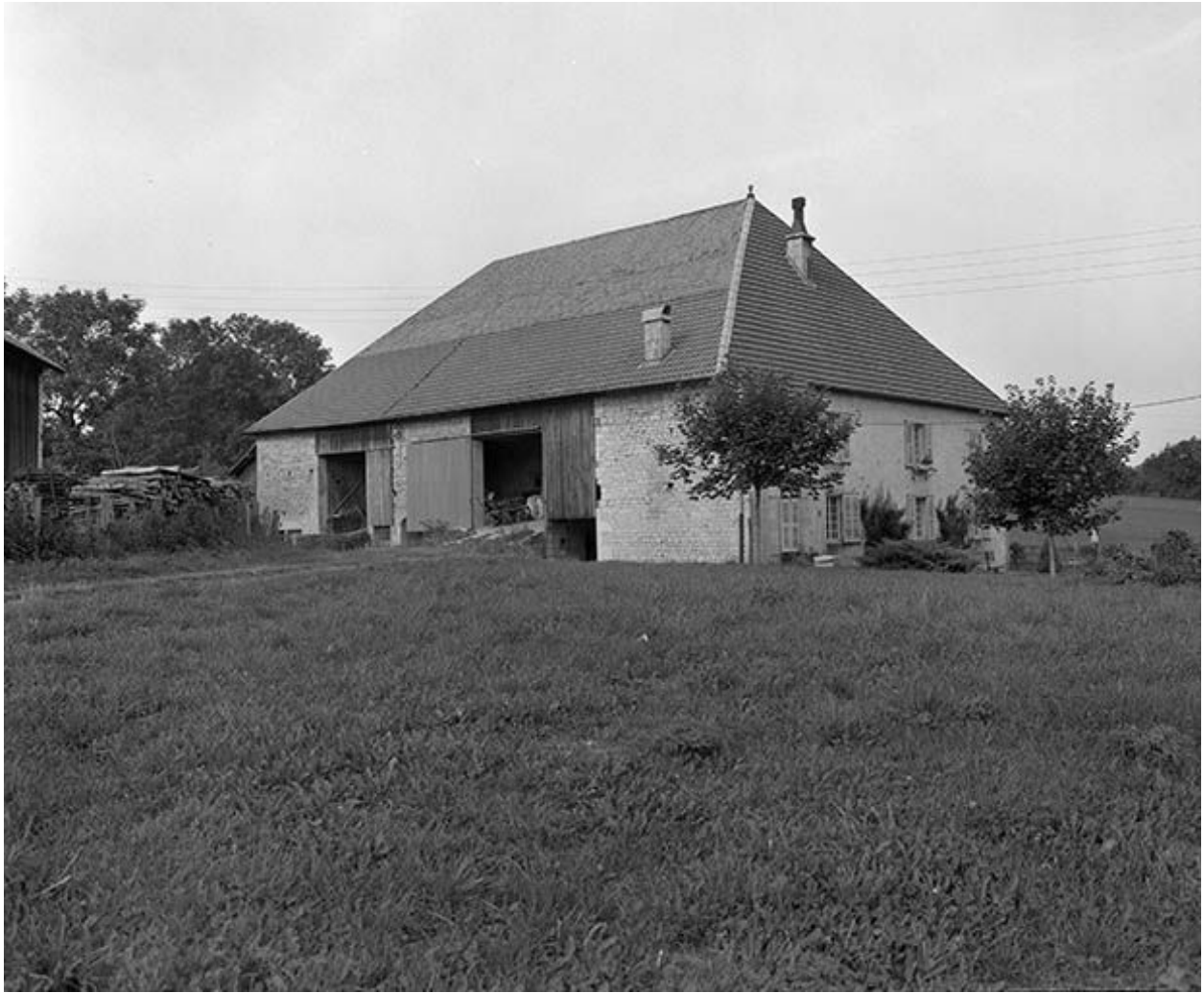
Façade postérieure et face latérale gauche.
