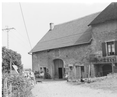
Façade antérieure. Phot. Yves Sancey
