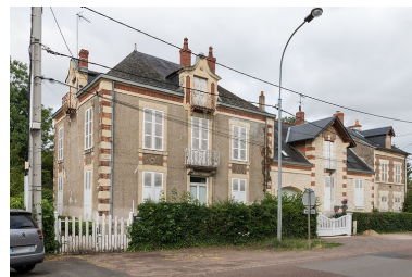
Vue d'ensemble. Phot. Pierre-Marie Barbe-Richaud IVR26_20205800458NUC4A
