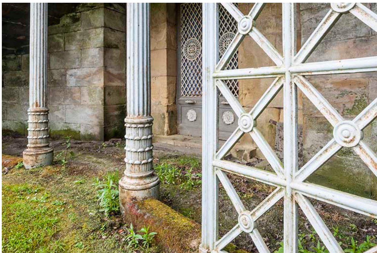
Détail sur l'armature métallique.
