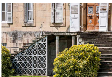
L'escalier double, façade sud. Phot. Jérôme Mongreville IVR43_20167000370NUC4A
