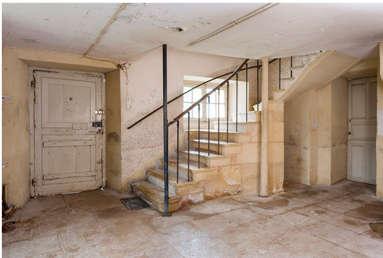
Escalier d'accès au rez-de-chaussée depuis le sous-sol.
