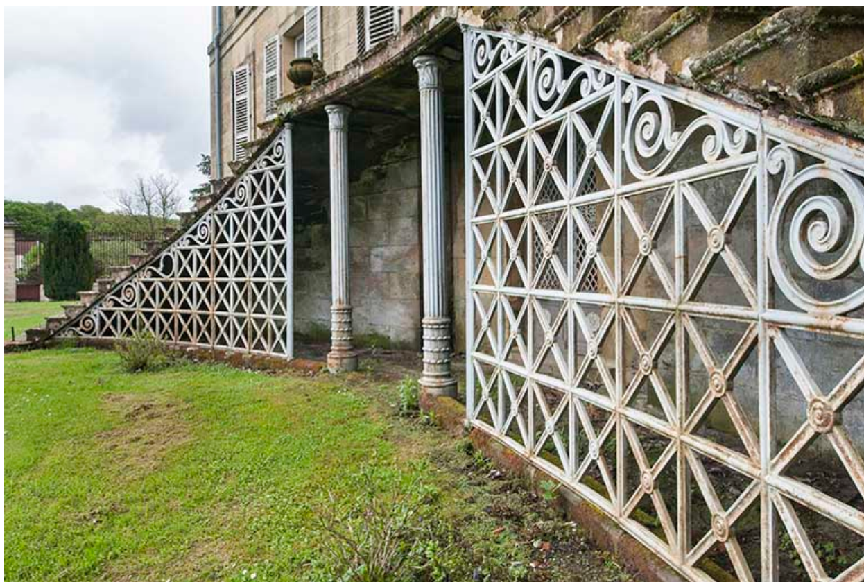
Structure métallique soutenant l'escalier.
