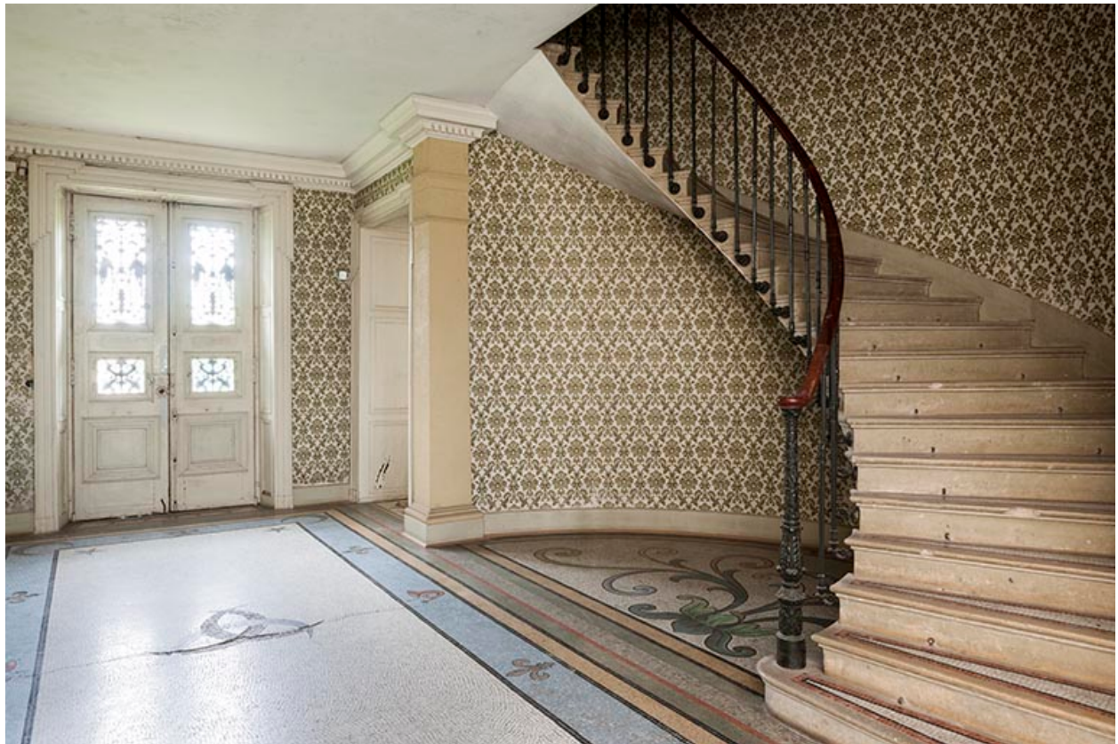
L'escalier en vis suspendu.
