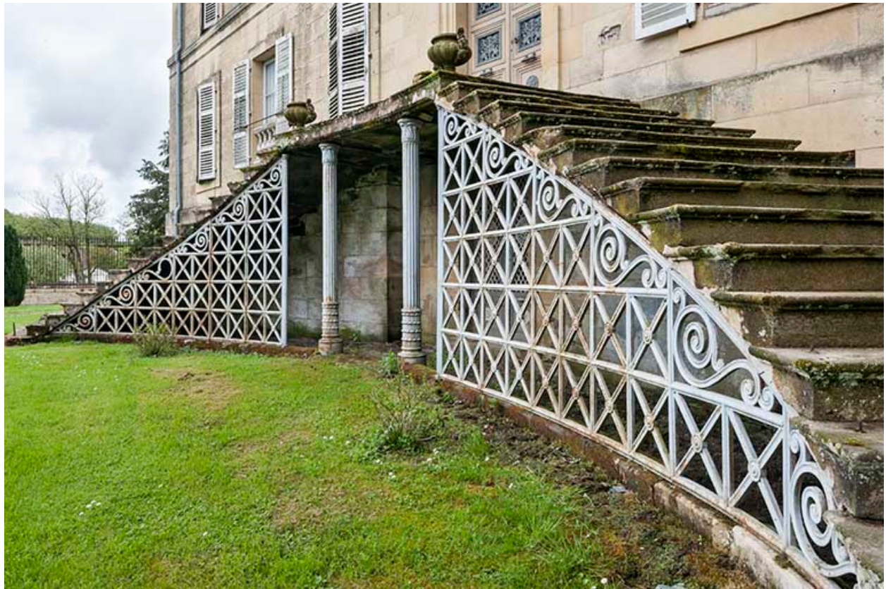
L'escalier double, façade nord.
