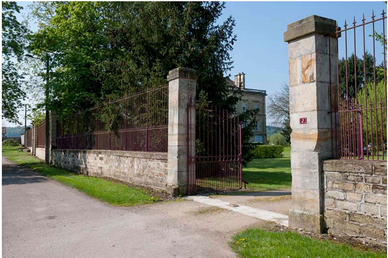
Portail d'accès aux parties agricoles.
