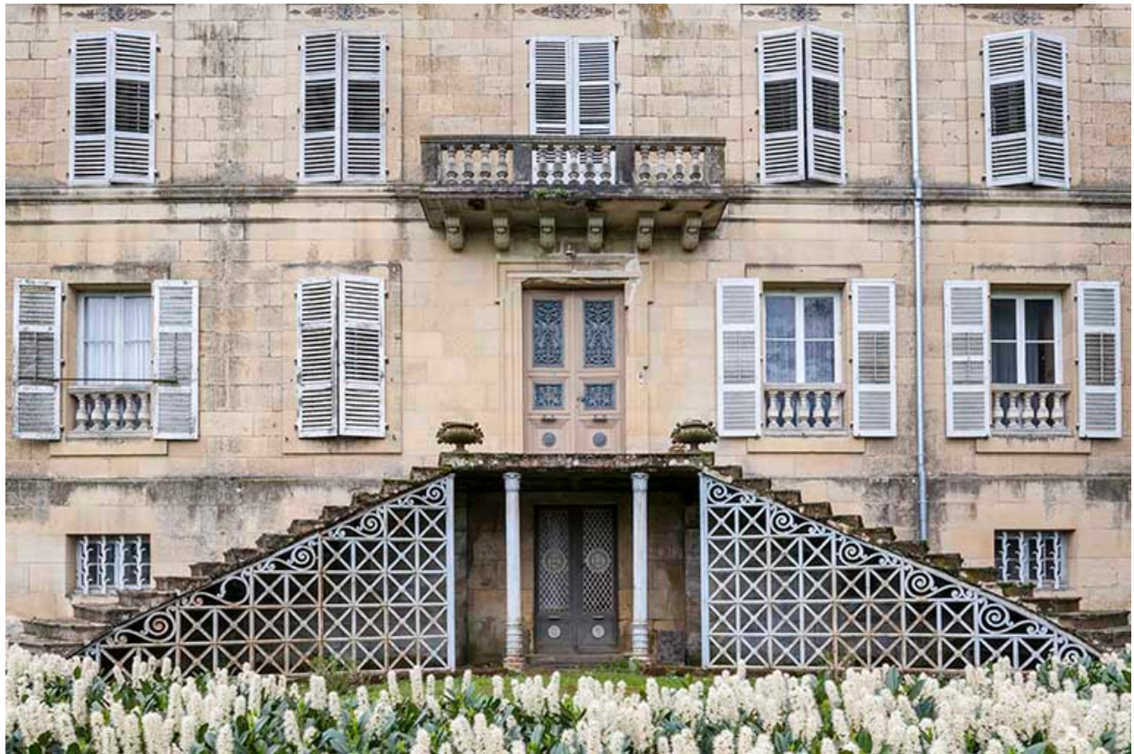
Vue générale, façade nord.
