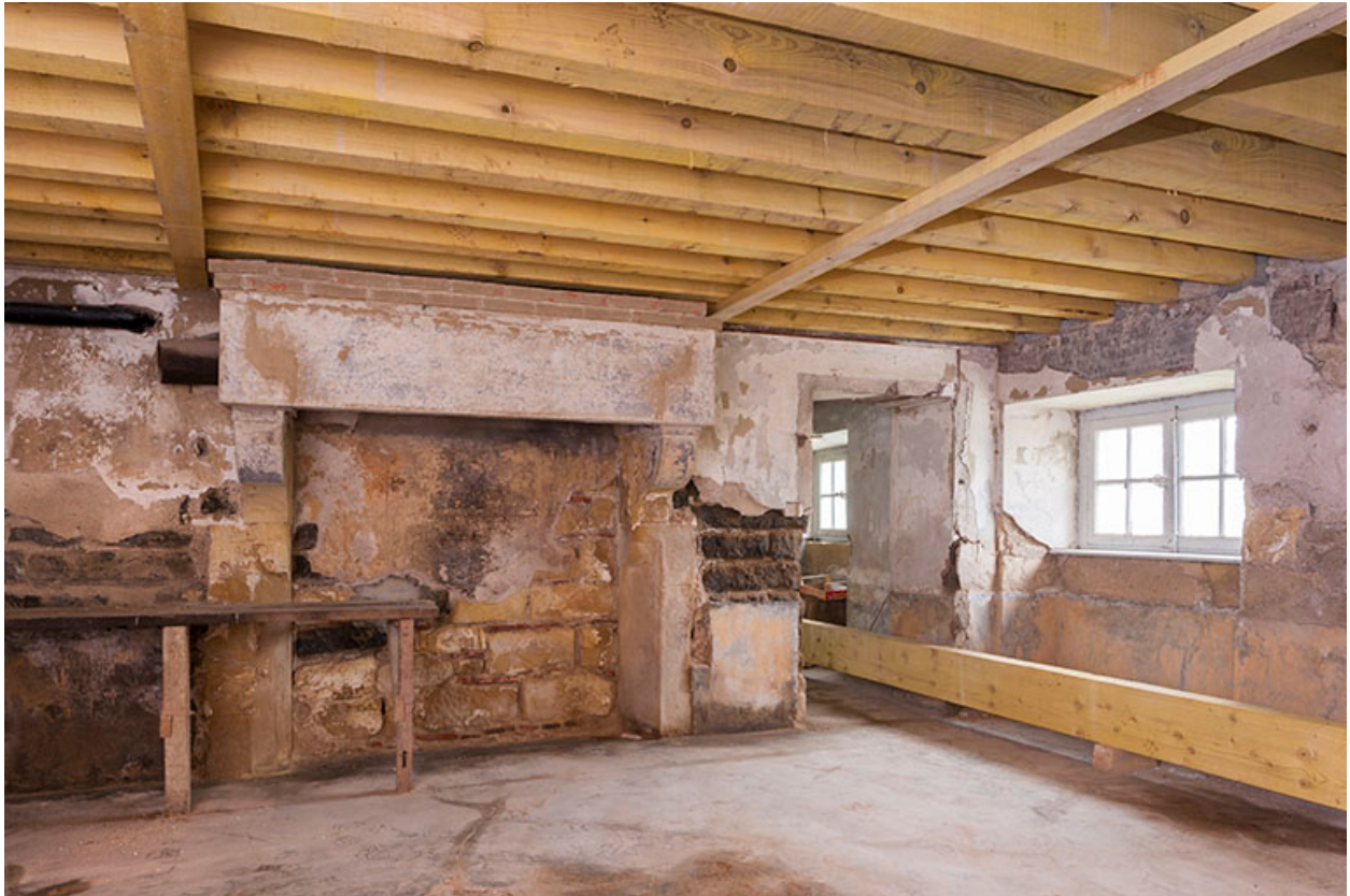
La cuisine du sous-sol et sa cheminée.
