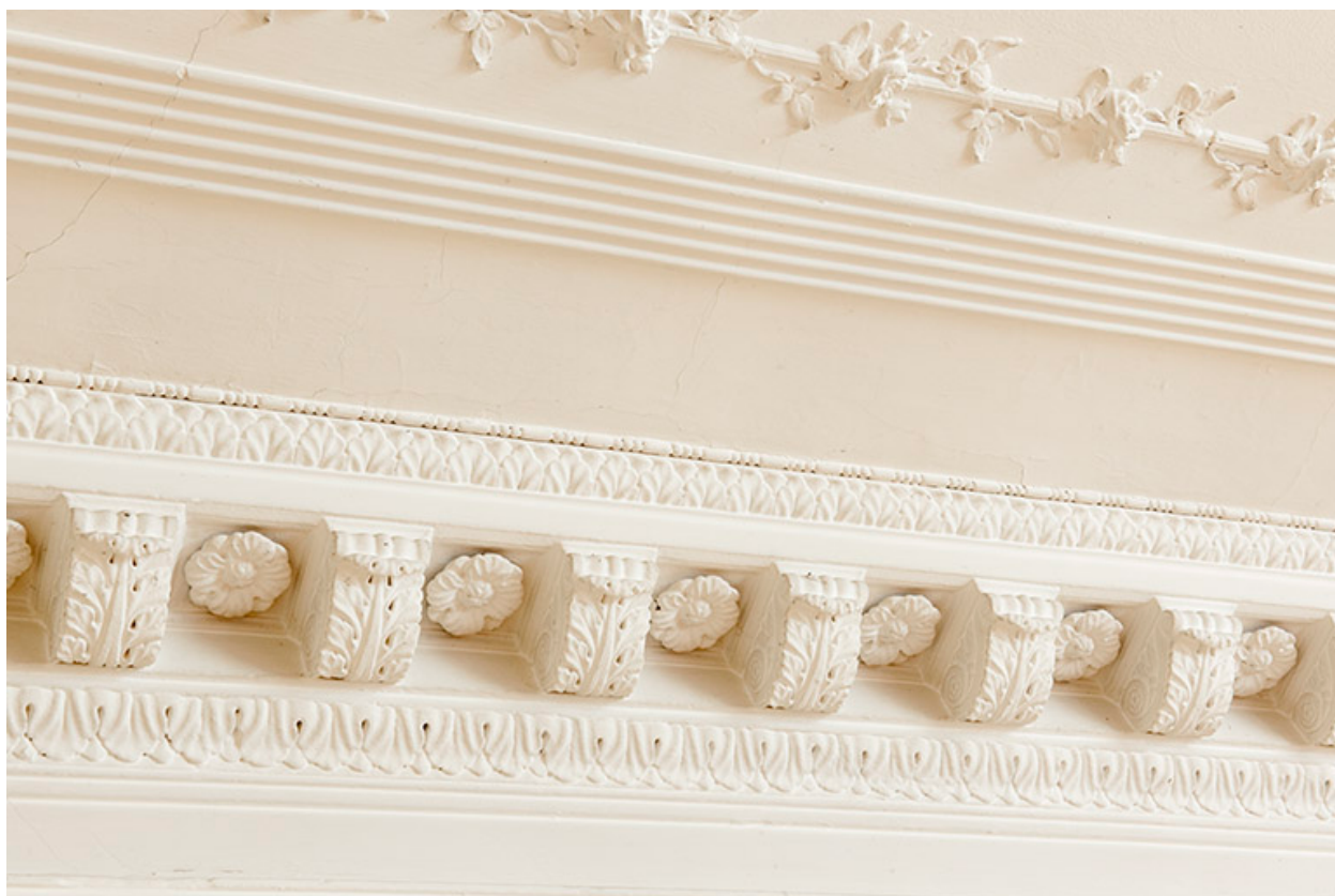
Détail de la corniche du plafond.
