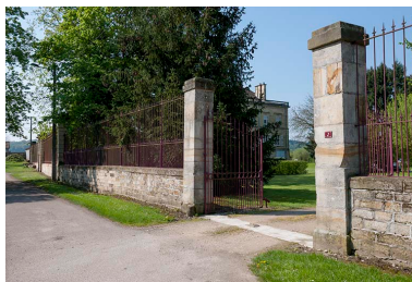
Portail d'accès aux parties agricoles.
