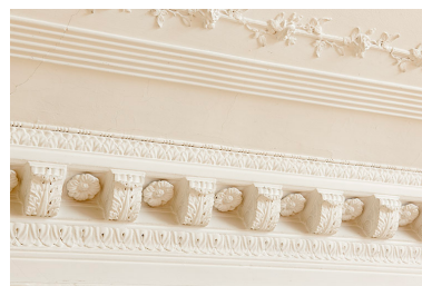
Détail de la corniche du plafond. Phot. Jérôme Mongreville IVR43_20167000863NUC4A
