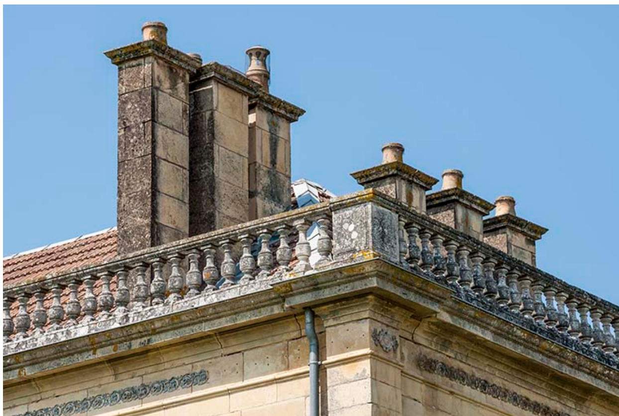
Balustrades et souches de cheminées.
