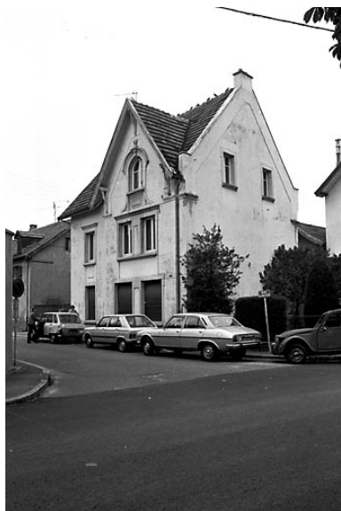
Vue d'ensemble. Phot. Bernard Lardière IVR43_19832500198Z
