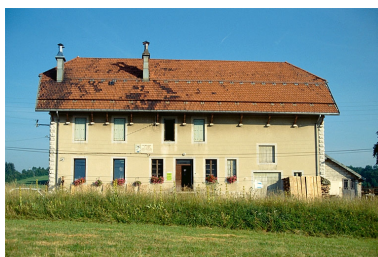
Façade antérieure. Phot. Laurent Poupard IVR43_19913901173ZA
