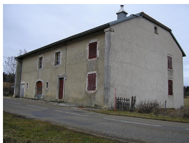
Ferme située au lieu-dit La Loye. Phot. Marie-Pierre Reynet IVR43_20083900516NUC1A
