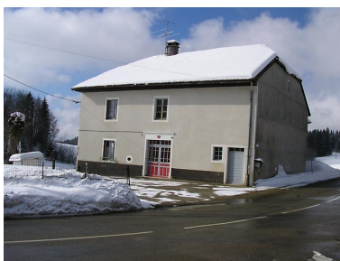
Ferme située au lieu-dit La Loye. Phot. Marie-Pierre Reynet IVR43_20083900525NUC1A
