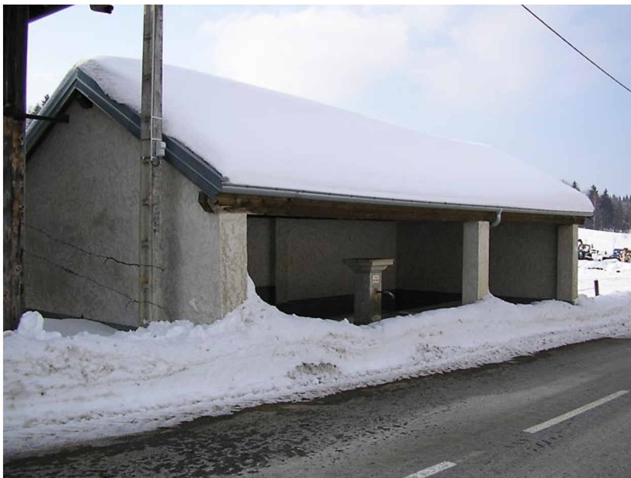
Fontaine-lavoir située rue des Lavoirs.
