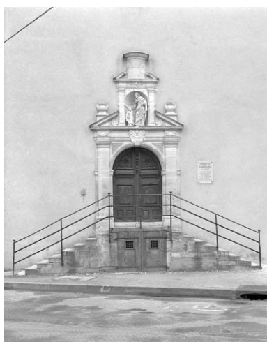
Chapelle : portail d'entrée. Phot. Yves Sancey IVR43_19897000438V
