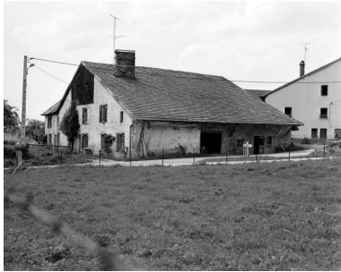
Vue de trois quarts droit. Phot. Bernard Lardière IVR43_19782500222X
