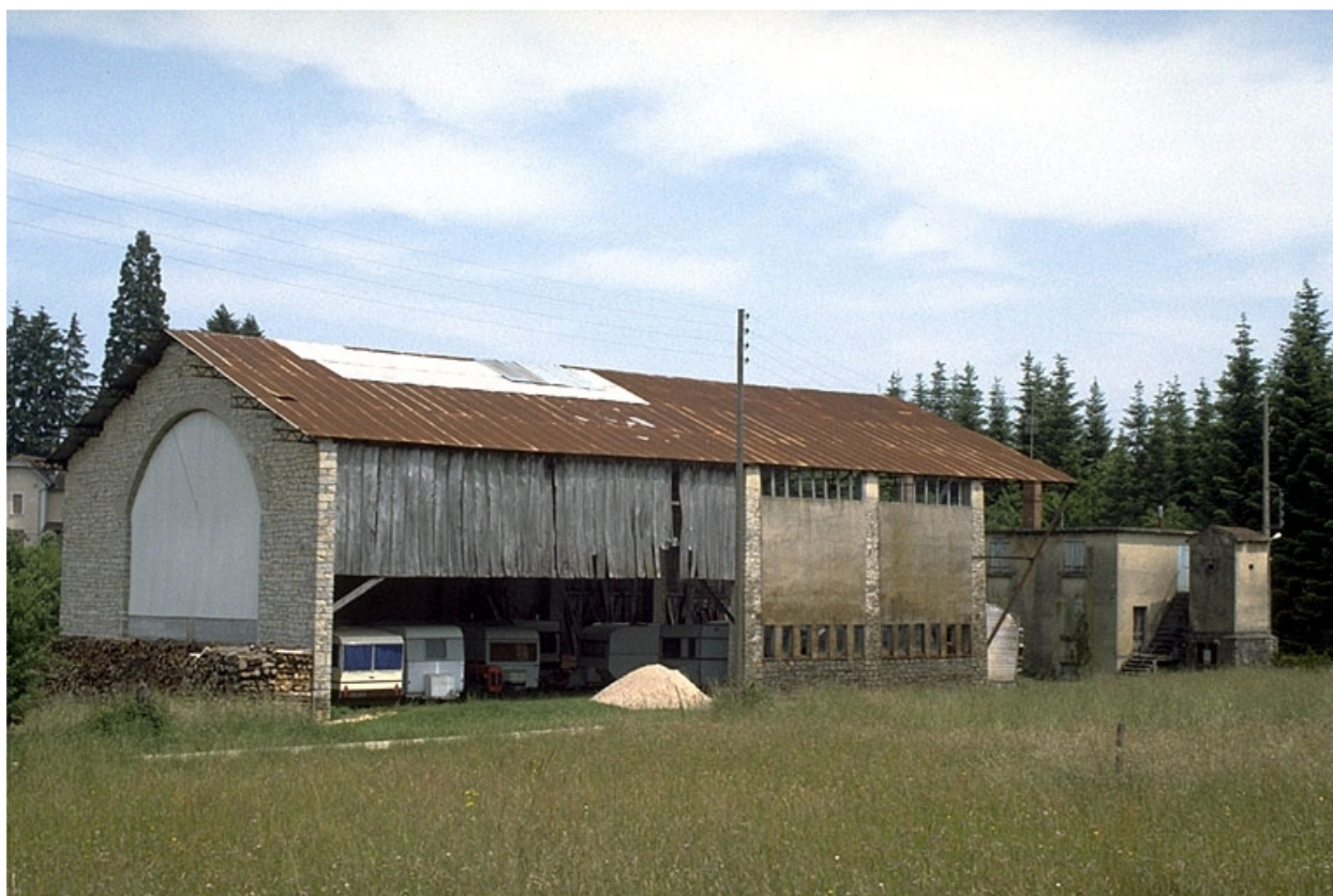
Atelier de fabrication (D).
