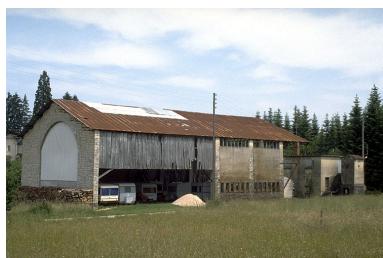
Atelier de fabrication (D). Phot. Laurent Poupard IVR43_19883900478ZA
