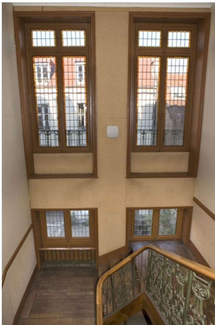
Détail des fenêtres éclairant l'escalier principal.
