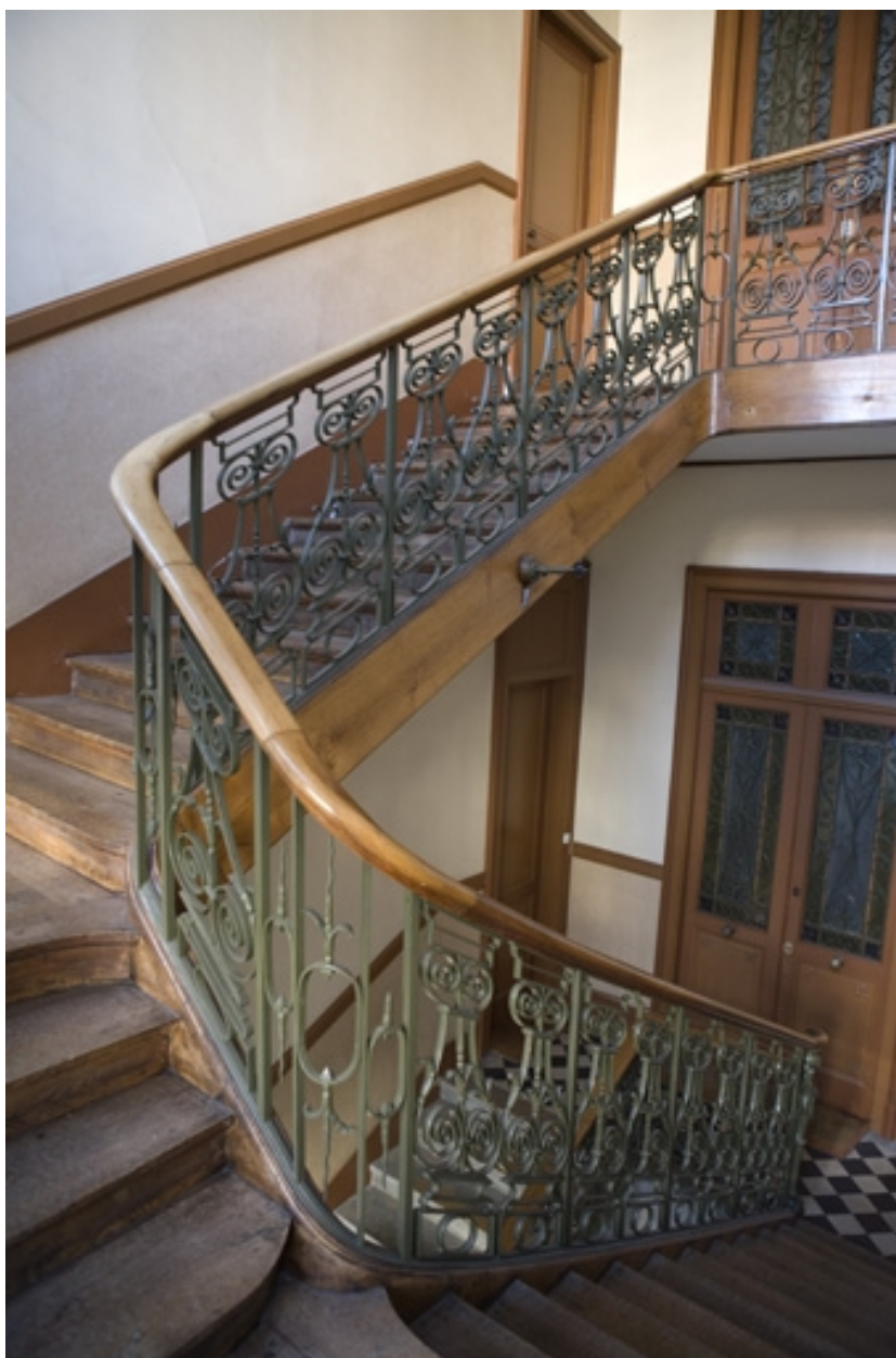
Vue d'ensemble de l'escalier principal.
