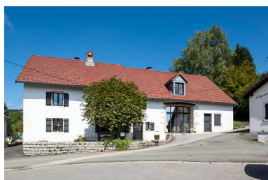
Ferme : façade antérieure.
