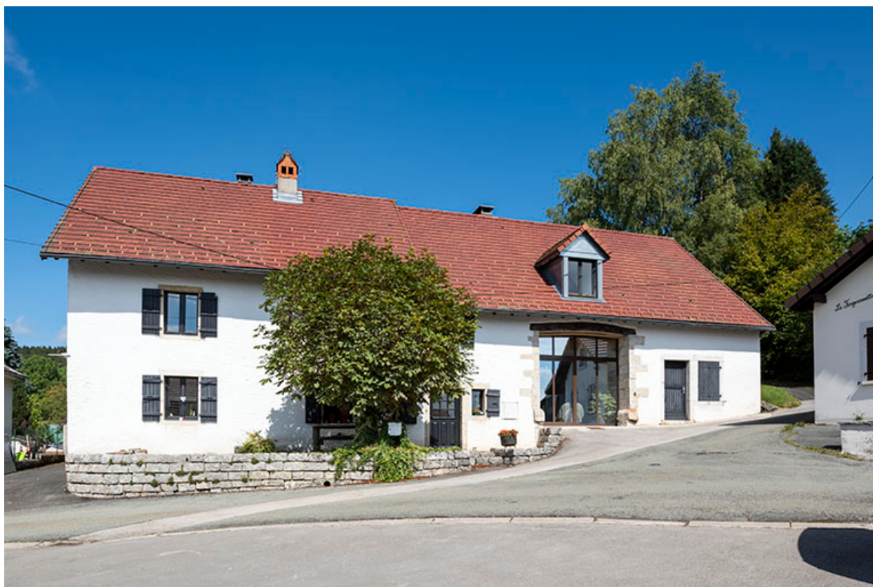
Ferme : façade antérieure.
