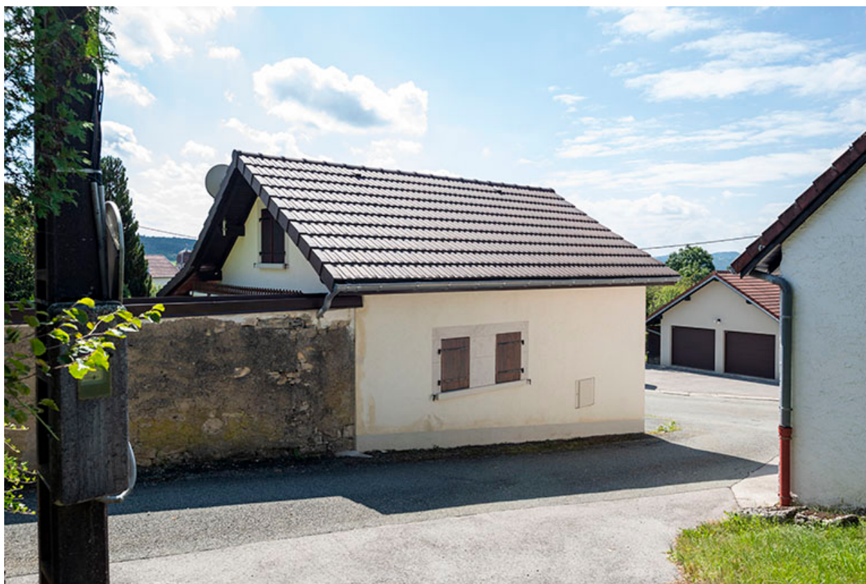
Nouvelle forge : façades postérieure et latérale gauche.
