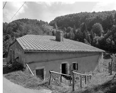
Face ouest. Phot. Jérôme Mongreville IVR43_19963901258X
