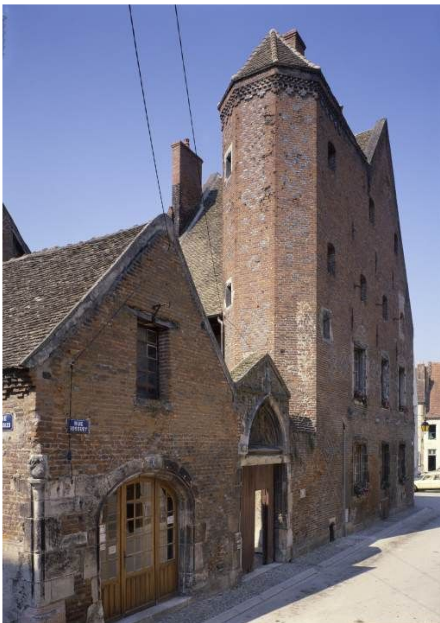
Façades sur la rue Bossuet.
