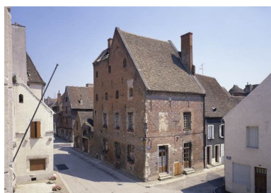
Vue d'ensemble. Phot. Michel Rosso IVR26_19862101585VA
