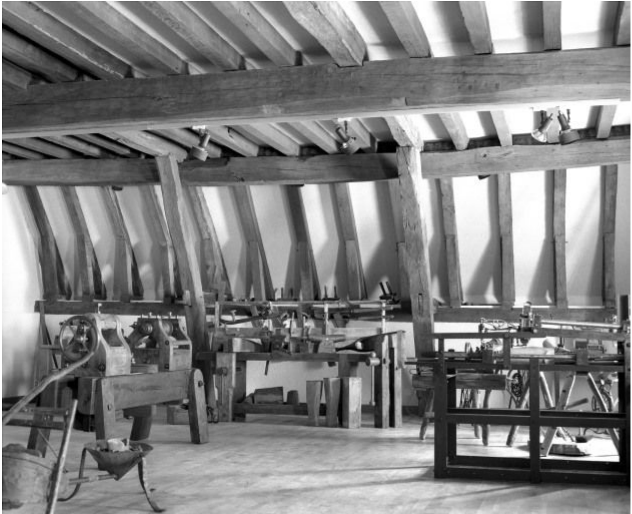
Charpente du niveau inférieur du comble.
