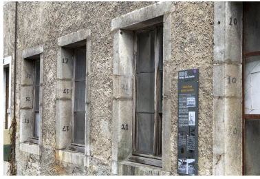
Chiffres peints sur les piédroits des fenêtres de la façade antérieure. Phot. Yves Sancey IVR43_20103900177NUC2A
