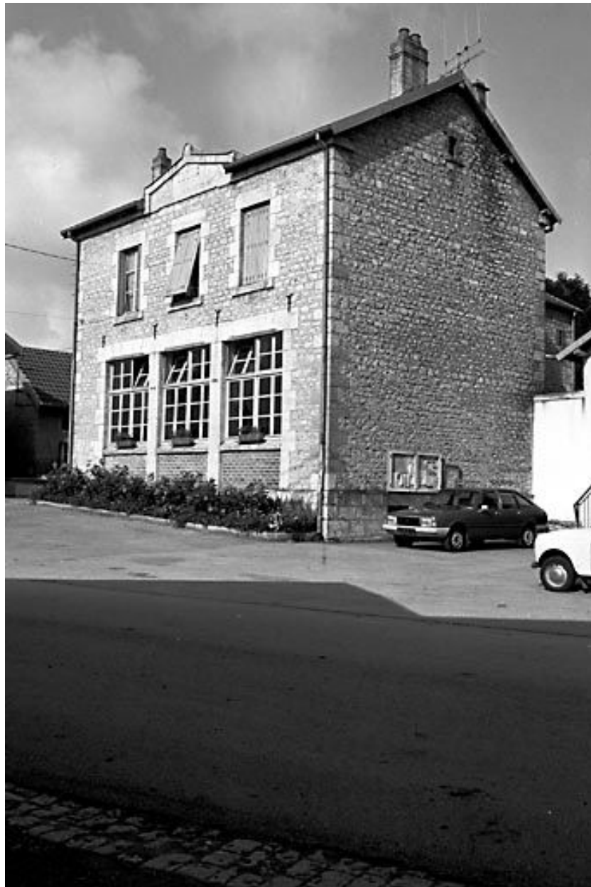
Façade postérieure et face latérale gauche.
