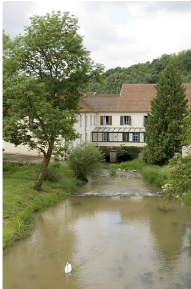
Bief d'amenée à l'usine. Phot. Jérôme Mongreville IVR43_20087000574NUC2A
