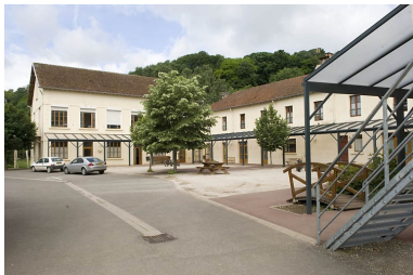
Ferme et orphelinat. Vue depuis l'est. Phot. Jérôme Mongreville IVR43_20087000571NUC2A
