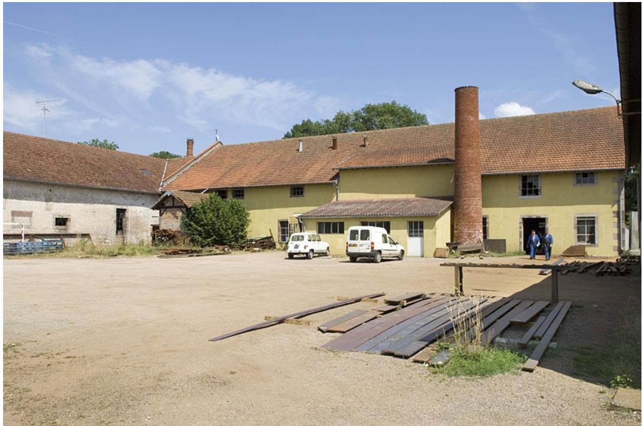
Bâtiments industriels depuis la cour.
