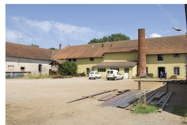
Bâtiments industriels depuis la cour. Phot. Jérôme Mongreville IVR43_20067000669NUDA
