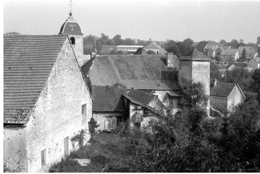
Façade postérieure. Phot. Bernard Lardière IVR43_19797000076Z
