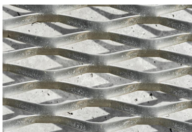
Résille métallique : détail. Phot. Pierre-Marie Barbe-Richaud IVR26_20212100463NUC4A
