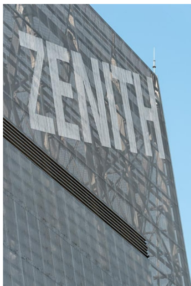
Inscription Zenith sur la façade-écran. Phot. Pierre-Marie Barbe-Richaud IVR26_20212100432NUC4A
