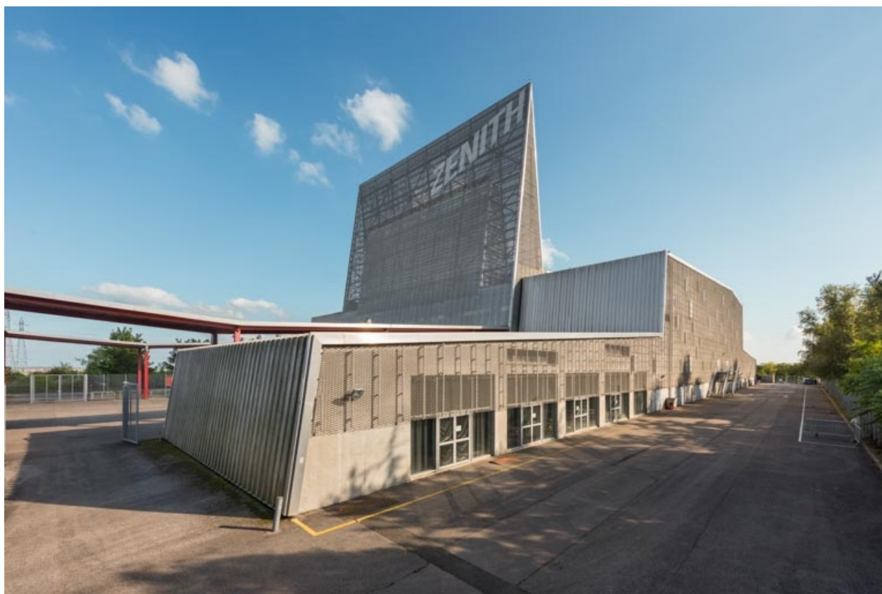
Façade latérale droite, de trois quarts gauche.
