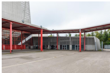
Portique et salle de réception. Phot. Pierre-Marie Barbe-Richaud IVR26_20212100444NUC4A
