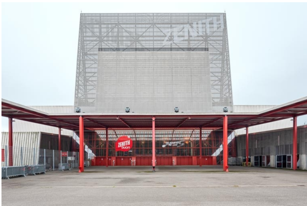
Corps principal, avec portiques et façade-écran.
