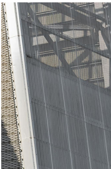
Bardage de la façade-écran. Phot. Pierre-Marie Barbe-Richaud IVR26_20212100431NUC4A
