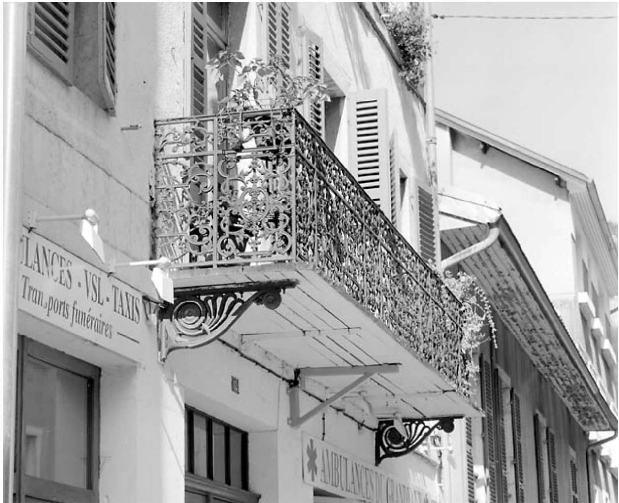
Elévation antérieure : balcon.
