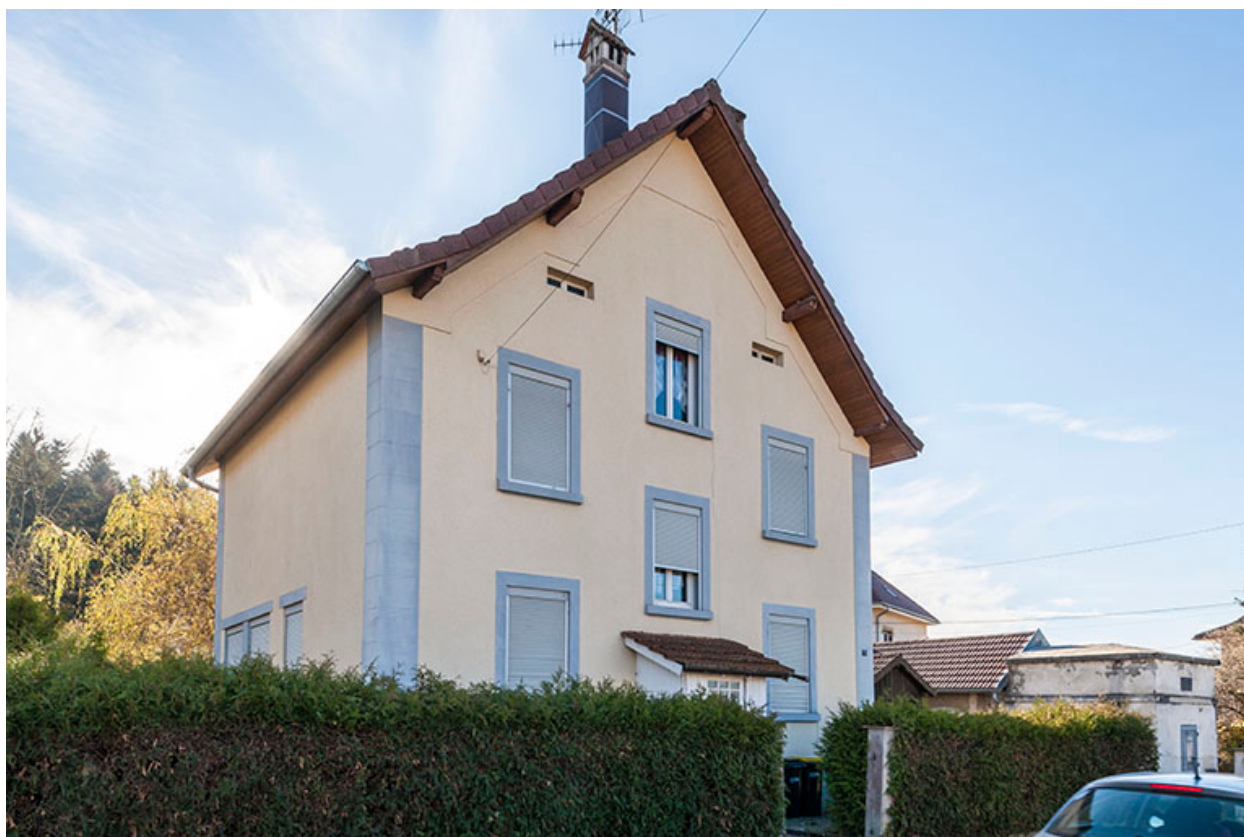
Façades antérieure et latérale gauche.
