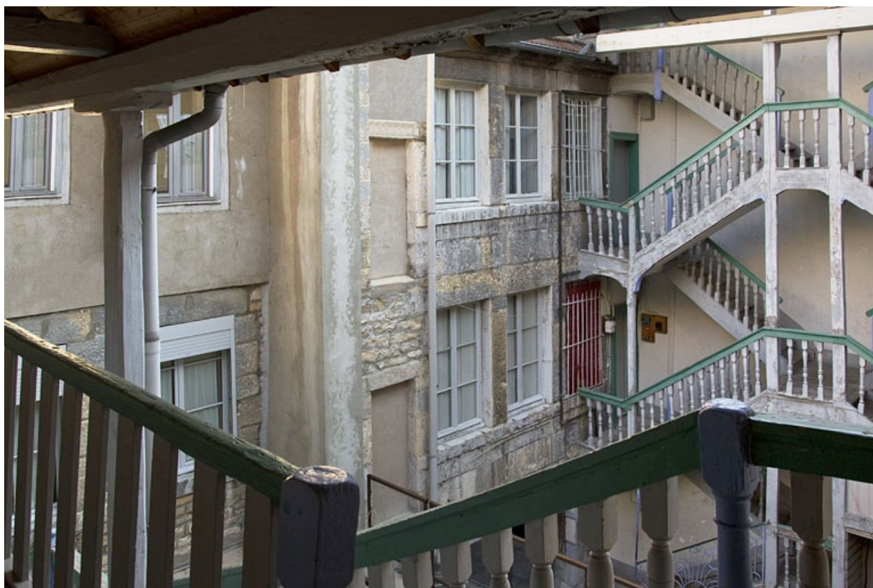
Vue de la première cour.
