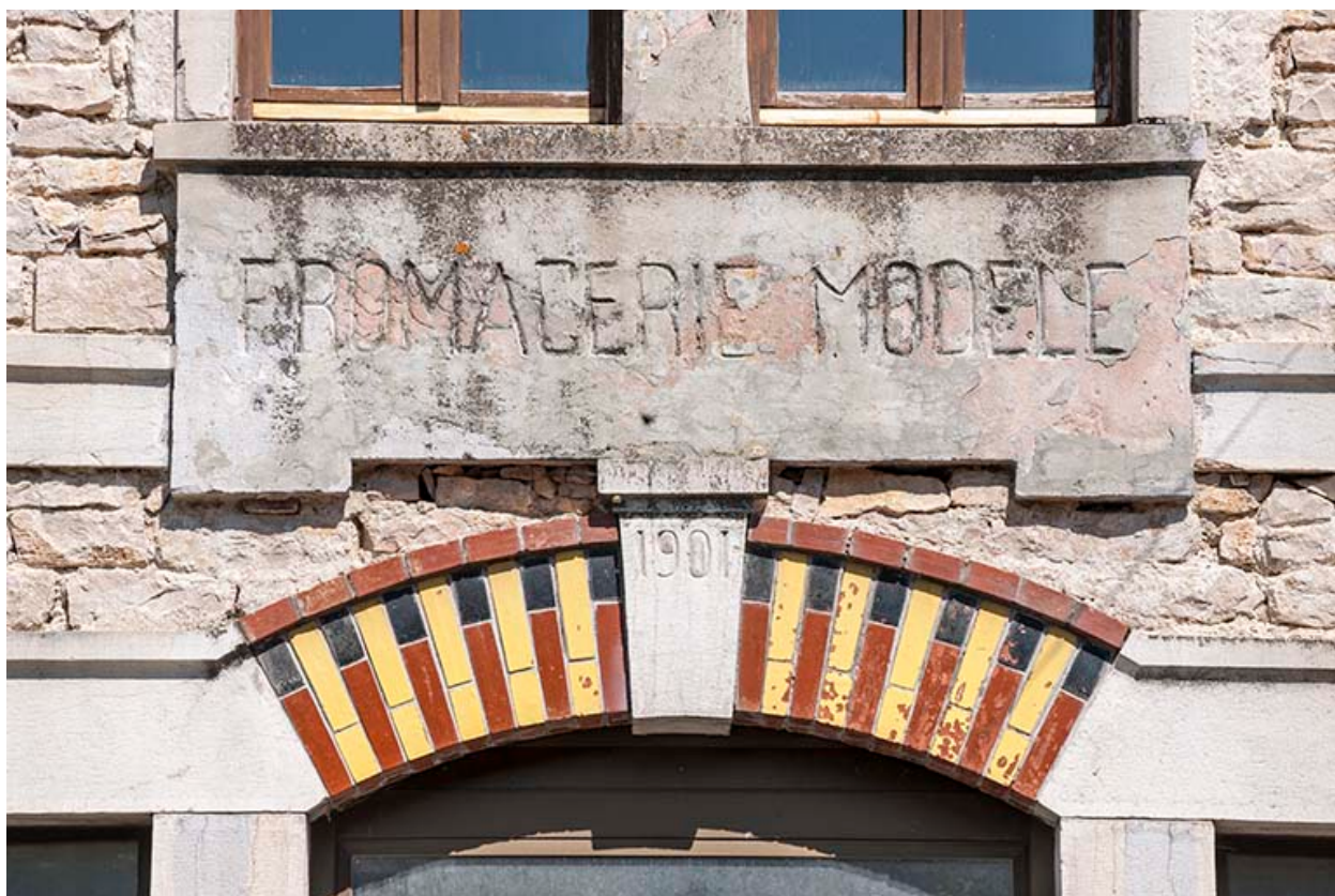
Façade sud. Inscription sur le pignon.
