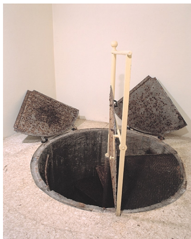
Sous-sol, salle ouest : puits des pendules à pression constante, trappe partiellement ouverte. Phot. Jérôme Mongreville IVR43_20022501188XA
