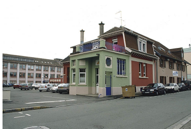
Conciergerie. Phot. Yves Sancey IVR43_20009000608ZA
