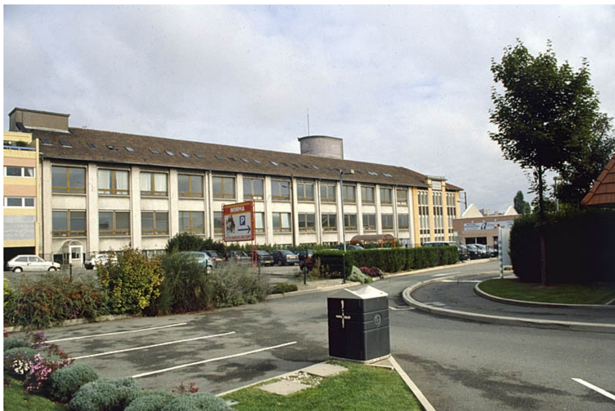
Extension sud de l'atelier de fabrication.
