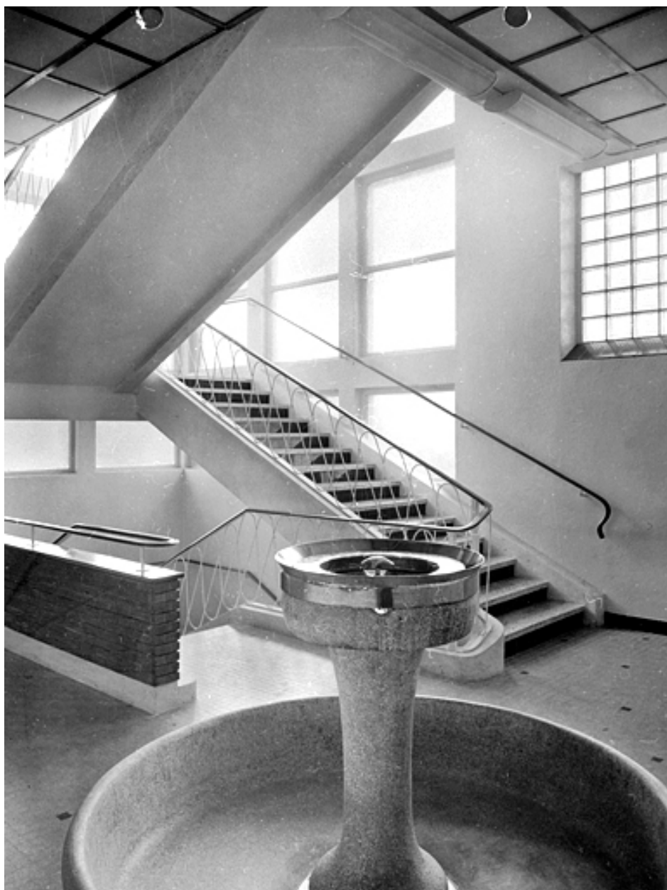
Vue intérieure du nouvel escalier.
