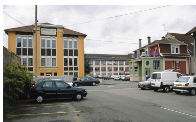
Vue de l'entrée depuis le nord. Phot. Yves Sancey IVR43_20009000606ZA
