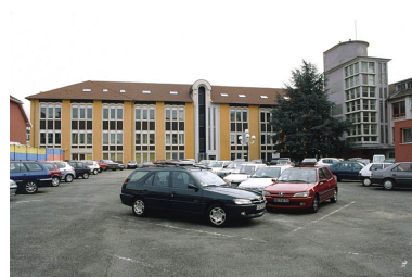
Façade ouest de l'atelier depuis la cour. Phot. Yves Sancey IVR43_20009000621ZA
