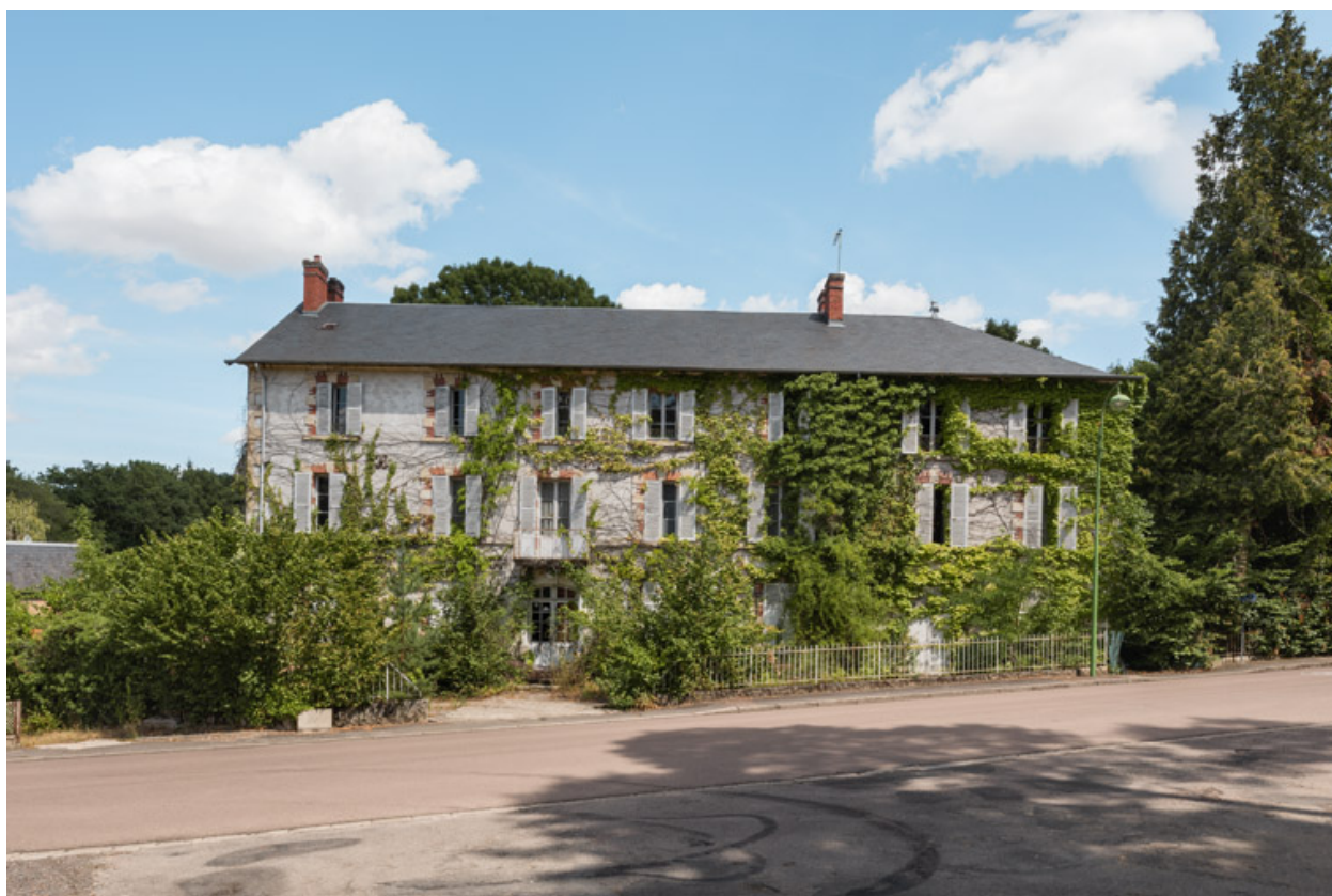
Façade sur la rue.
